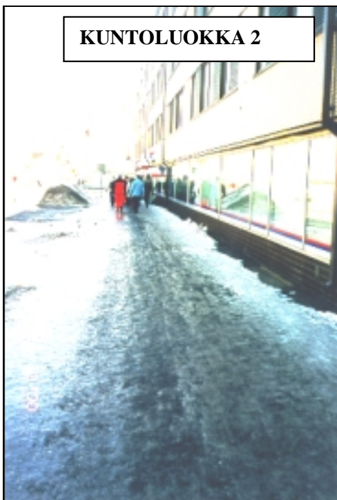
Kuva 11. Höyläämätön käytävä sai arvostelua käyttäjiltä.
