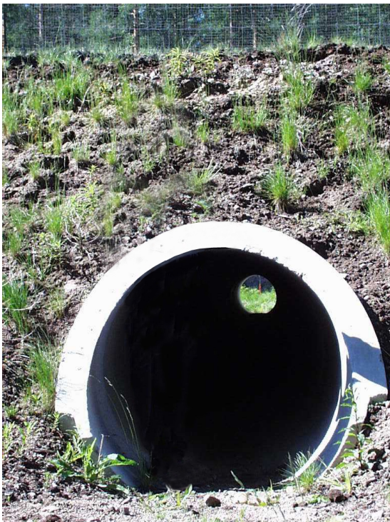
Kuva 23: Betoninen pieneläinputki tierakenteen läpi. Bild 23: Et betong smådjur rör genom väg konstruktionen.
