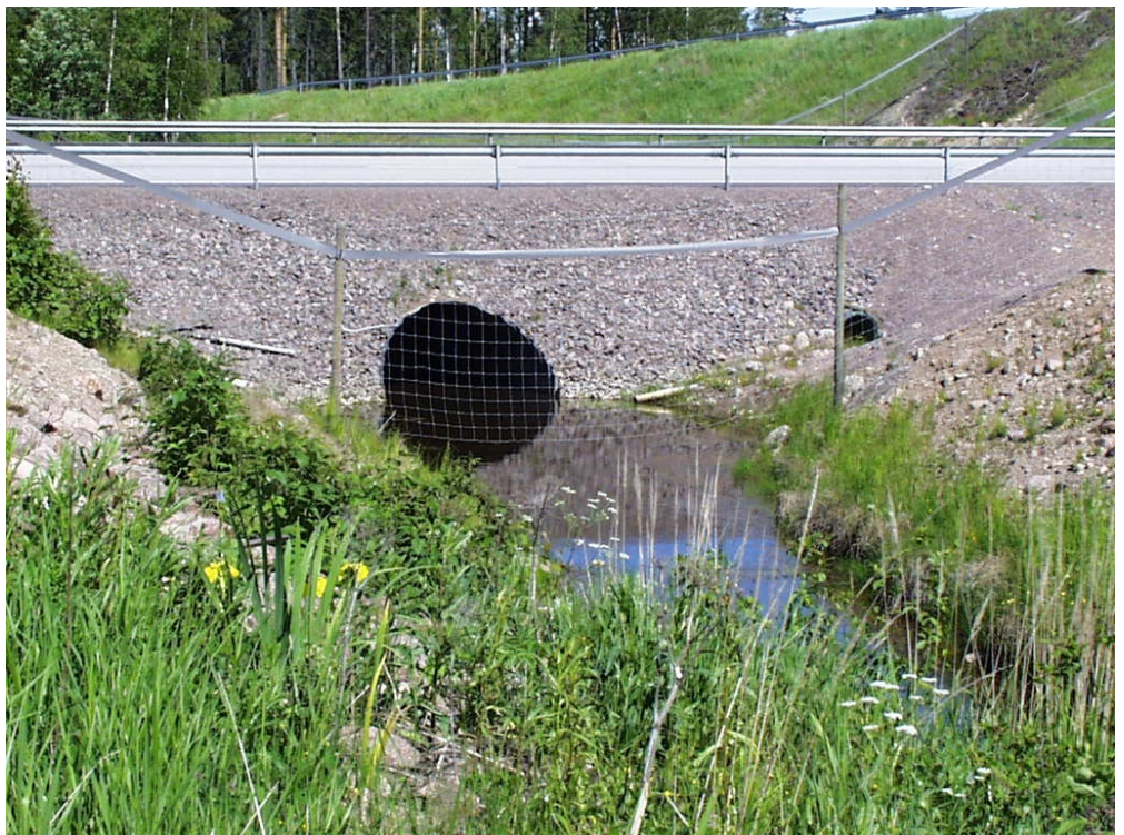
Kuva 5: Vesistörunpu S9, kuiva reunas sillan alla puuttuu, mutta oikealla on erillinen kuiva pieneläinputki. Bild 5: Vattenkulvert S9, den torra kanten under bron saknas, men mot höger finns ett smådjurrör.
