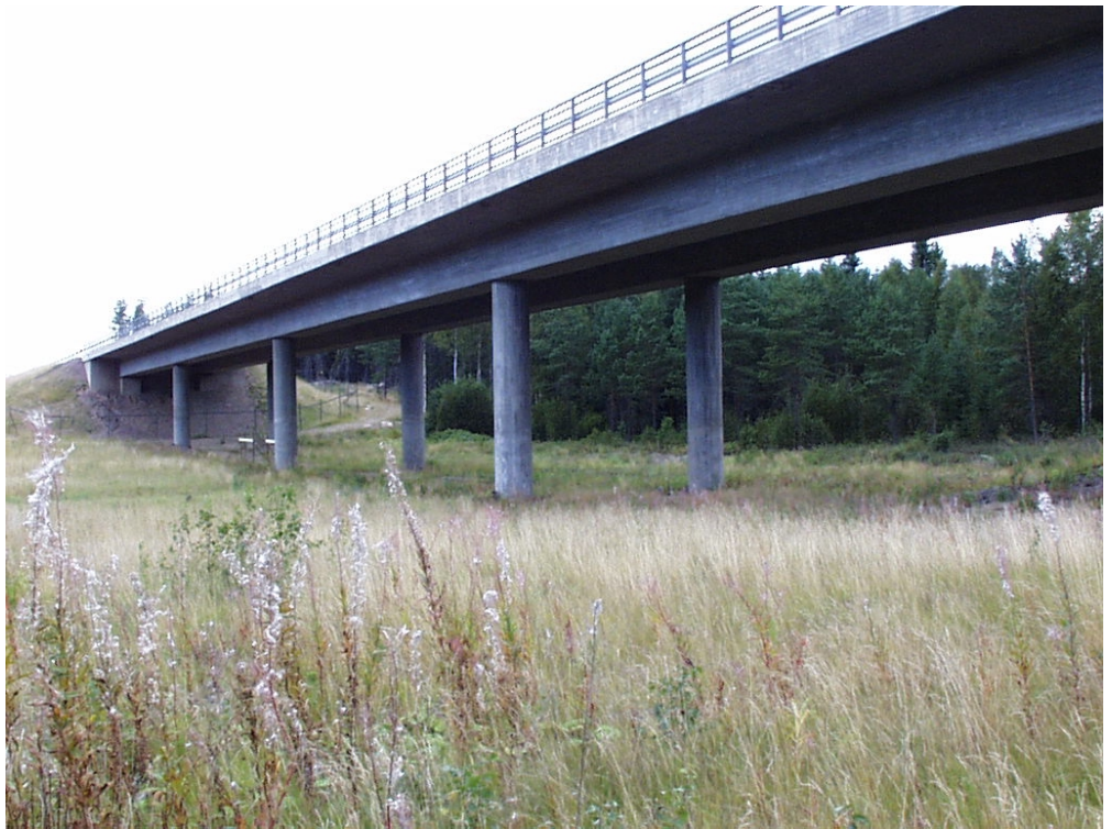
Kuva 4: Suuri hirvisilta H6, hirviliikenteen käytetyin alikulku. Bild 4: Den stora älgbron H6, den mest använda undergången.
