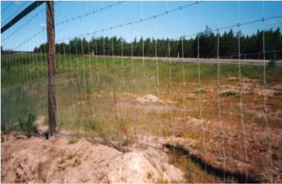
Hirviaitaan kiinnitettyä tiheäsilmäistä verkkoa vt 7:lla Pernajassa. Verkko ohjaa eläinten kulun niille suunniteltuihin pieneläinputkiin.
