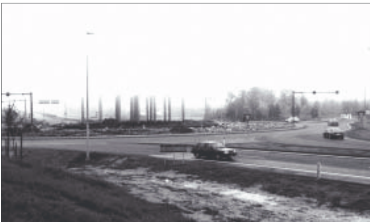
Kuva 23. Röyttän kiertoliittymä (kuva Kemin suunnasta).
