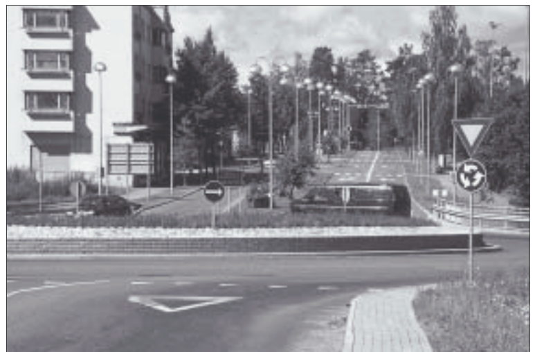
Kuva 18. Vaajakoskentie tehokkaat valaisimet saattavat muo- dostaa kiertoliittymälle pimeässä kirkkaan taustan ja vaikeuttaa liittymän havaittavuutta.
