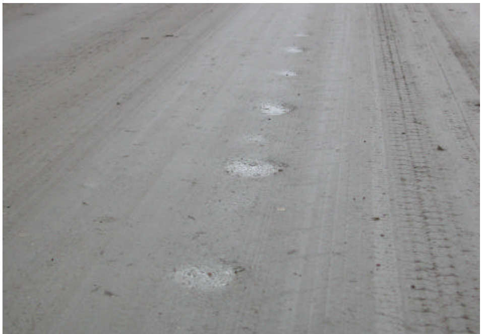
Kuva 14. Koeosuuden no. 4 (1 x Zed + 250 kg suola) pinta muuttumassa lievästi reikiintyväksi syksyllä 2001.
