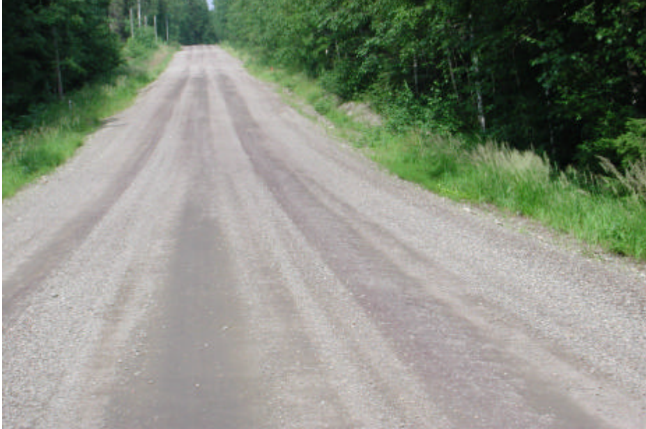
Kuva 18. Koeosuuden 2B irtosoraisuus näkyy hyvin 18.07.2001 otetussa seuranta-kuvassa.
