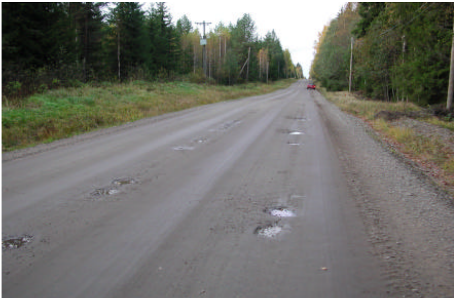
Kuva 19. Alkavaa kuopan/reiän muodostusta koeosuudella 1A syksyllä 2001.
