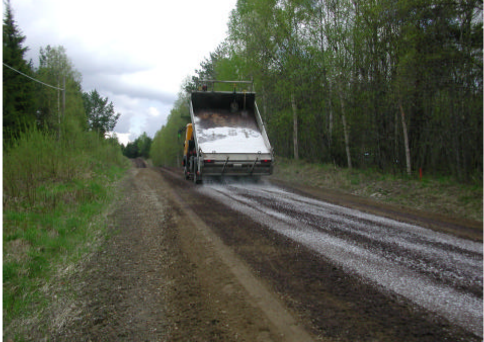
Kuva 13. Yhdistelmäosuuden no. 4 (1 x Zed + 250 kg suolan levitys) seuranta, aloitusvaihe kevät 2001.
