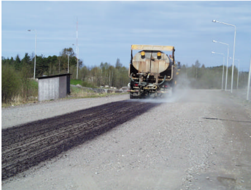
Kuva 10. Puun kuoriliuotteen ruiskutus höylättyyn soratien pintaan esikokeessa. Pinta karkeampi kuin varsinaisessa kokeessa.
