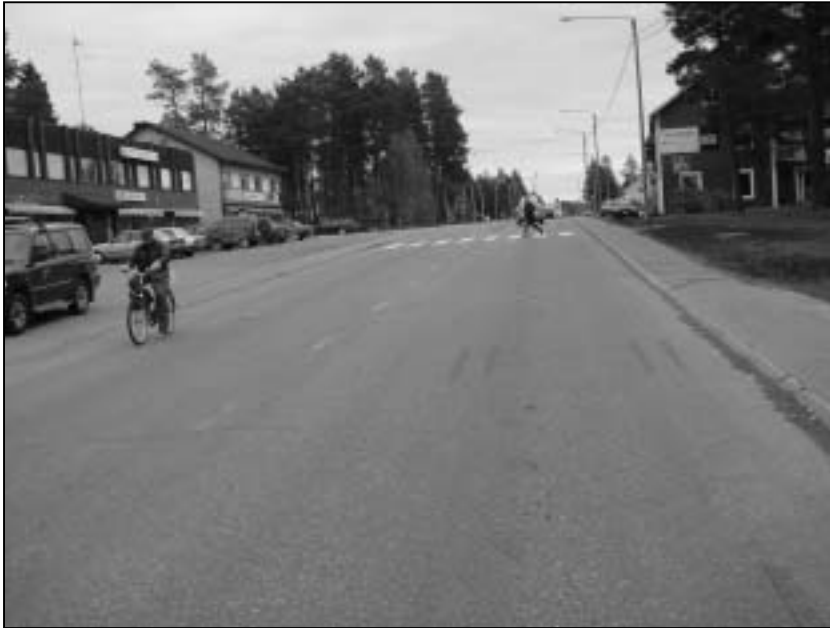
Vaalantie (seututie mt 879) on Vaalan kirkonkylän pääväylä. Kuva Koulutien liittymästä koilliseen (mittauspisteet 3 ja 4).
