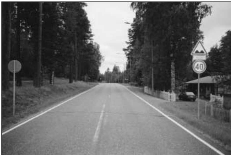
Kontiolahden Asemankylään Kontiolahden paikallistielle 15720 kesällä 2002 rakennettujen suoja-tien etutöyssyjen yhteydessä nopeus-rajotus 60 km/h pu-dotettiin 40 km/h:ksi. Kuva etelään noin 80 m ennen suojatietä.
