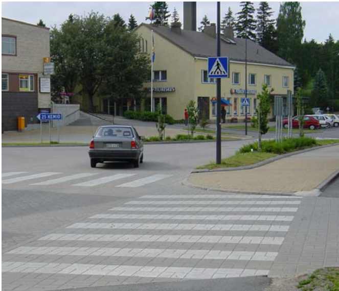
Kuva 9. Suojatie alkaa pyöritykseltä siten, että reunakivilinjasta kohtisuoraan lähtevä näkövammaisen jalankulkija saattaa ajautua ajoradalle (luokka 3).
