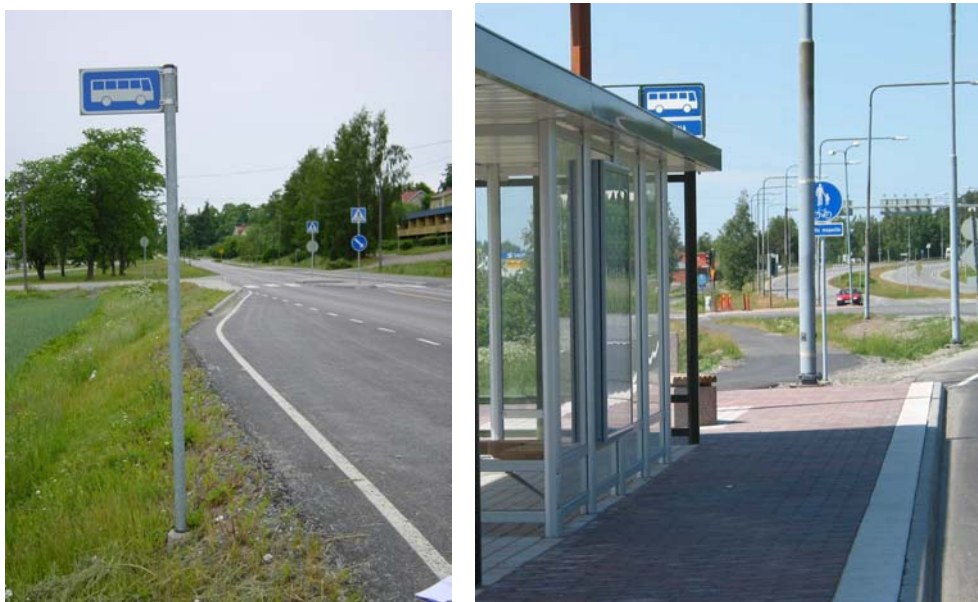
Kuva 17. Vasemman puoleisessa kuvassa odotustila puuttuu kokonaan (luokka 4). Oikean puoleisessa kuvassa odotustila on erotettu ajoradasta reunakivellä ja värikontrastilla (luokka 2).
