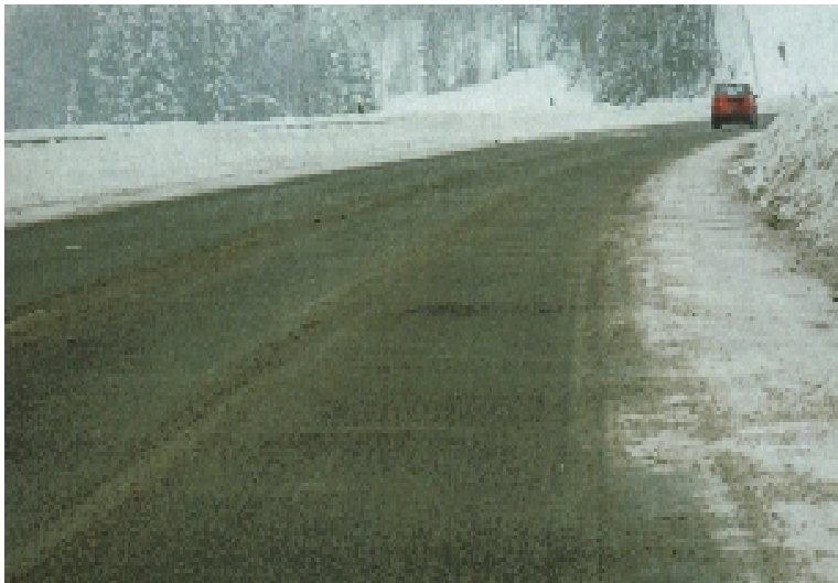
Kuva 34. Epätasaisia kohoumia talvella 1998 E4 vid Höga Kusten Bro tiellä Ruotsissa (kuva Höpeda 1999a).
