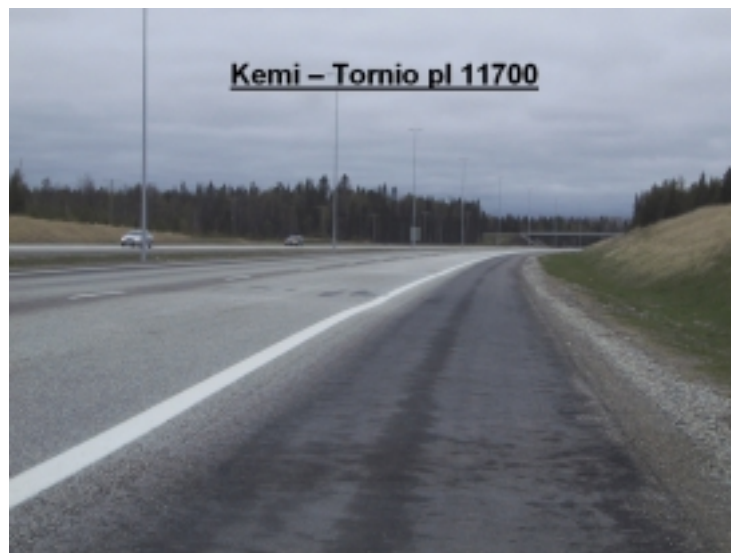
Kuva 43. Routaheitto paalulla 11 700 suunnassa Kemi - Tornio. Heitto sijoittuu leikkauksen ja penkereen siirtymäkiilan kohdalle ja se syntyi vasta myöhään kevättalvella, jolloin routa oli edennyt syvälle pohjamaahan.
