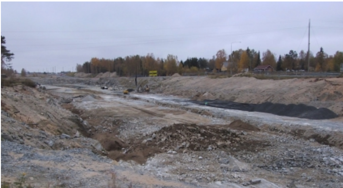
Kuva 2. Keminmaan kallioleikkaus noin paalulla 19600 rakentamisvaiheessa syksyllä 2000. Kuvassa näkyvää kuonahiekkaa käytettiin putkitusten ympäristötäyttöihin.
