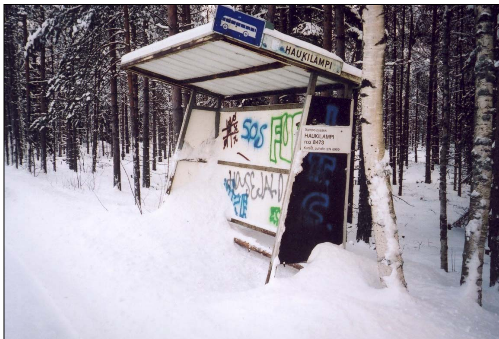
Kuva 1 Pysäkkikatos tien aurauksen jälkeen.
