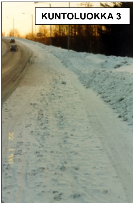
Kuva 39. Korotetulle osuudelle on lentänyt lunta ajoradalta (kohde 10).
