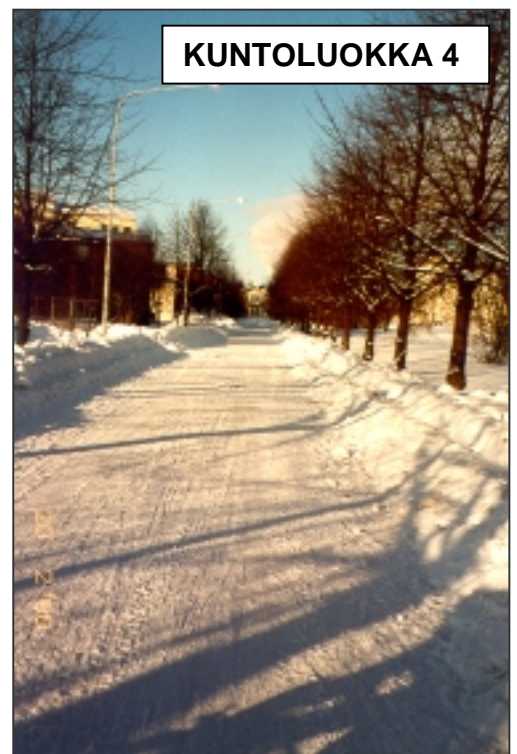
Kuva 48. Pienikin määrä irtolunta ja vähäinen epätasaisuus pudottivat arvosanat 5:sta 4:een. Kuntoluokka = 4. Tutkimusryhmäläisten antamien arvosanojen ka = 4,16 (Oulu, Myllytulli, 20.2.2000). Lumi oli tässä kohteessa merkittävin kuntoluokkaa alentava tekijä (7/25) ennen epätasaisuutta (5/25).
