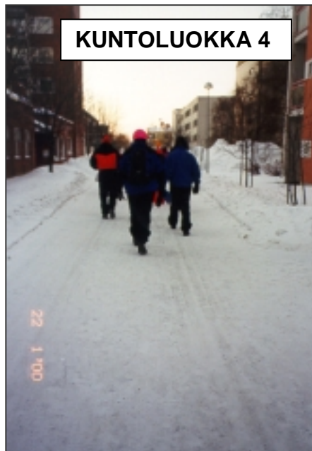
Kuva 53. Tutkimusryhmäläisistä 15/25 mielsi liukkauden kuntoluokkaa alentavaksi tekijäksi. Kuntoluokka =4. Arvosanojen KA = 3,96.
