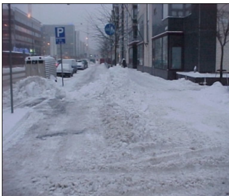
Kuva 17 Aurausjärjestelyissä on toivomisen varaa, pyörätie on aurattu, jalankulkukäytävä ei. Lunta on lisäksi jostain pukattu auratulle pyörätielle. Helsinki, Itämerenkatu 20.1.2000
