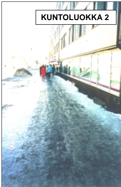
Kuva 45. Tälle jalankulkukäytävälle ei karhennusta ole tehty. Hiekka kulkeutuu painaumiin ja väylä on edelleen liukas. Tutkimusryhmäläisten antamien arvosanojen KA = 2,17. Kuntoluokka = 2 (huono). Liukkaus 24/24, epätasaisuus 17/24.
