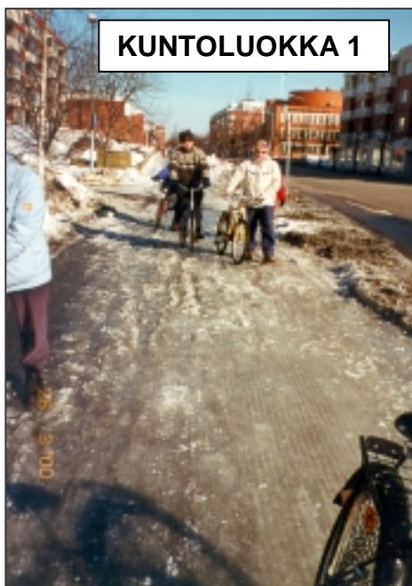
Kuva 49. Väylälle pakkautunut lumi aiheuttaa pyöräilyä häiritsevää epätasaisuutta. Väylän kapeus vaikeuttaa tasaiseksi höyläystä. Kuntoluokka = 3. Tutkimusryhmäläisten antamien arvosanojen ka = 3,32 (Oulu, Keskusta 20.2.2000). Epätasaisuus oli merkittävin kuntoluokkaa alentava tekijä (16/25) ennen lunta (11/25).
