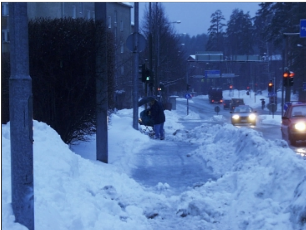
Kuva 14. Tämä kiinteistön hoitovastuulla oleva väylä oli täysin tukossa 13.12.1999. Tarve auraukselle havaittiin aamulla 10:30, eikä väylää ollut aurattu vielä 14:55 mennessä. Kohteella havaittiin reilu alitus.
