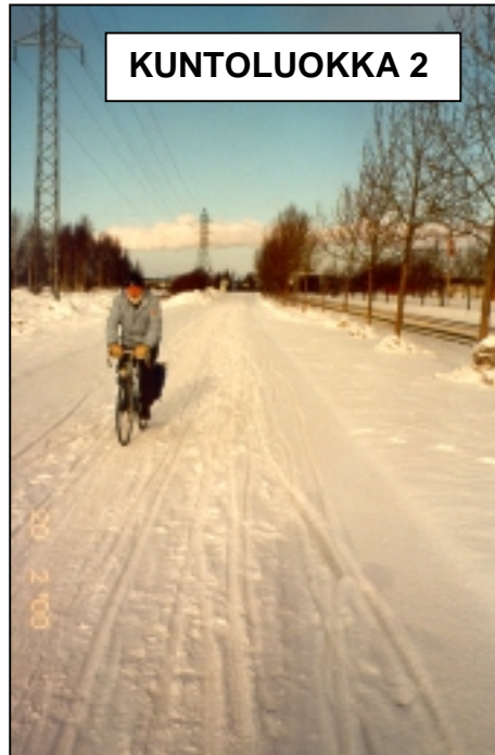
Kuva 50. Epätasaisuus ja lumisuus vaikeuttavat liikennöitävyyttä. Kuntoluokka 2. Tutkimusryhmäläisten antamien arvosanojen ka = 2,08 (Oulu, Limingantulli, 20.2. 2000). Lumi ja epätasaisuus saivat 22 mainintaa kuntoluokkaa alentavana tekijänä.
