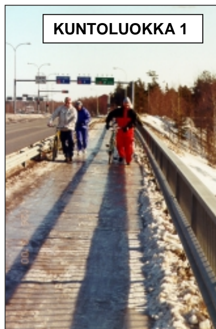
Kuva 44. Pohjantien ongelmallinen ylikulku (kohde 4).
