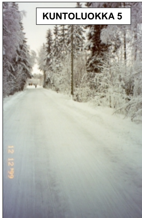
Kuva 47. Erittäin tasainen ja lumesta puhdas väylä. Karhea lumipolanne ei vaadi hiekoitusta. Kuntoluokka 5 = erittäin hyvä. Tutkimusryhmäläisten antamien arvosanojen ka = 4,64 (Oulu, Kuusamontie, 12.12.1999).
