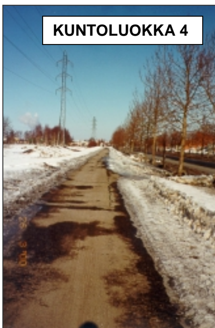
Kuva 43. Auringon sulattama paljas kevyen liikenteen väylä (kohde 9).
