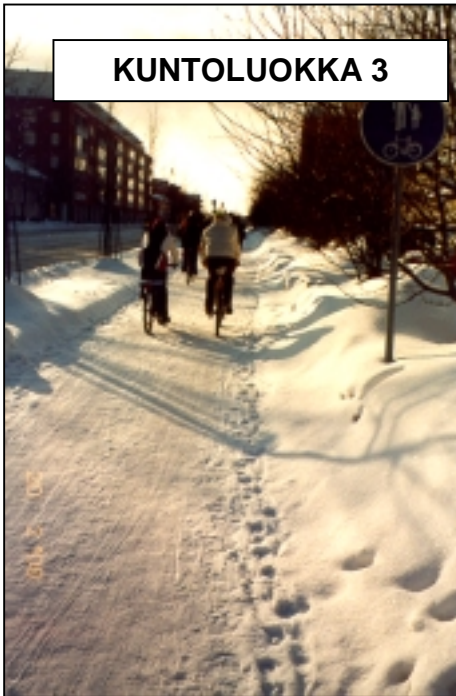
Kuva 49. Väylälle pakkautunut lumi aiheuttaa pyöräilyä häiritsevää epätasaisuutta. Väylän kapeus vaikeuttaa tasaiseksi höyläystä. Kuntoluokka = 3. Tutkimusryhmäläisten antamien arvosanojen ka = 3,32 (Oulu, Keskusta 20.2.2000). Epätasaisuus oli merkittävin kuntoluokkaa alentava tekijä (16/25) ennen lunta (11/25).
