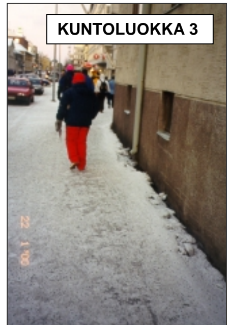
Kuva 54. Runsaskaan hiekoitus ei auta epätasaisuuksien hioutuessa liukkaiksi kohdiksi. Liukkaus (16/25) ja epätasaisuus (10/25) kuntoluokkaa alentavia tekijöitä. Arvosanojen KA = 3,4. Kuntoluokka=3.
