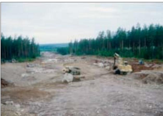
Kuva 1. Uutta moottoriliikennetielinjaa rakenteilla kesällä 1997.
