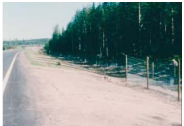
Kuva 3. Uuden valtatie leveä luiska Kärmmalmenin kohdalla. Etualalla paljasta hiekkamaata, taaempana vihreänä orastavaa kylvönurmea.
