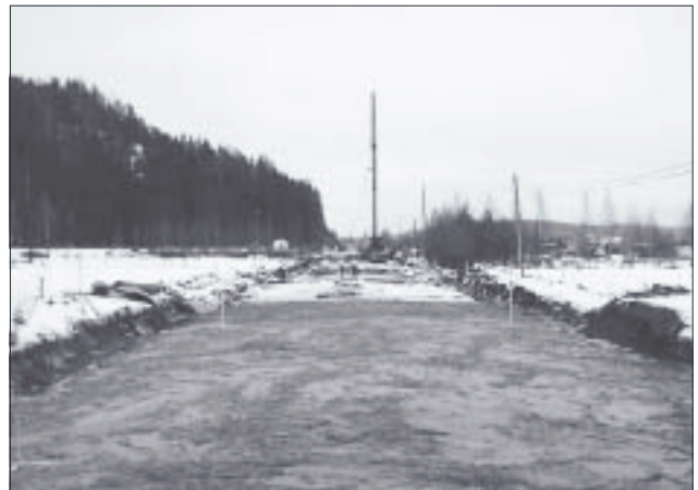
Kuva 12. Suojakerros rakennettu alueelle IV.
