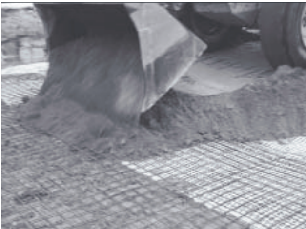
Kuva 18. Jakavan kerroksen levitys muovi- ja teräsverkkoalueen rajakohdassa.
