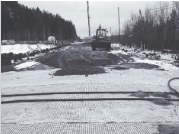
Kuva 13. Muoviverkot asennettu alueelle III.
