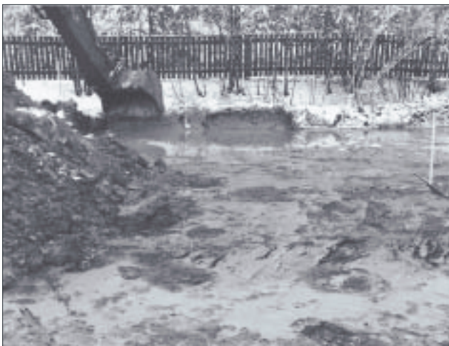
Kuva 11. Vanhan penkereen poisto käynnissä.
