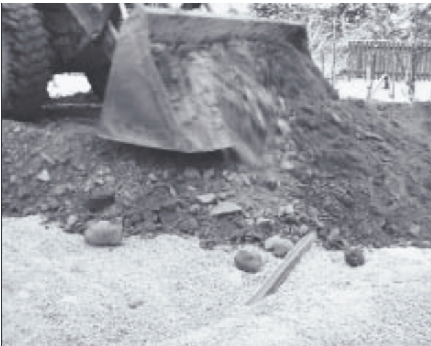
Kuva 17. Jakavan kerroksen levitys instrumentoidulla alueella.
