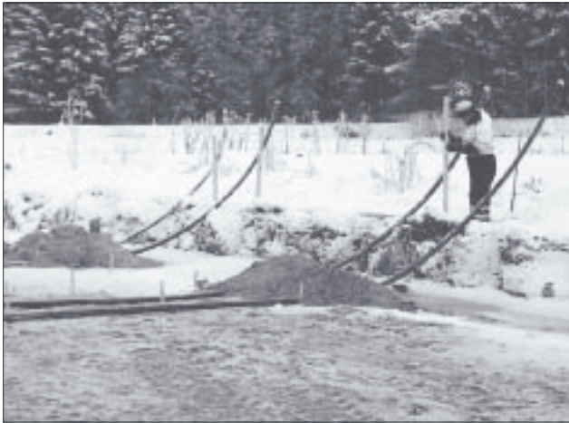
Kuva 15. Letkupainumamittarien asennusta alueelle II.
