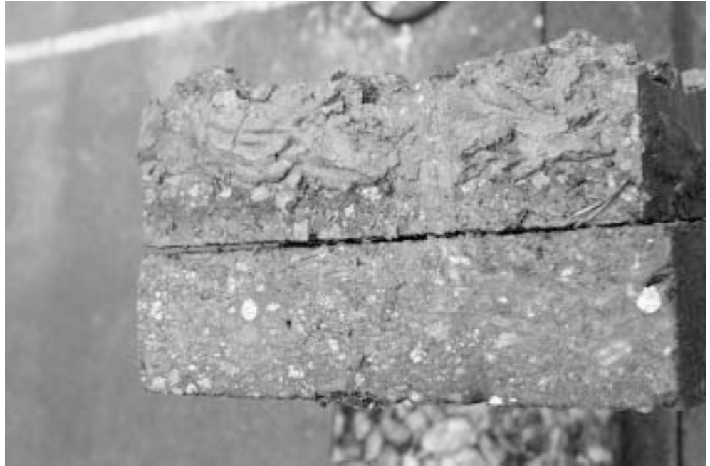
Kuva 4.4. Rakenteesta 25 sahattu päällystenäyte. Päällystekerrokset ovat irronneet toisistaan.
