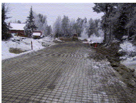
Kuva 8. Teräsverkon asentaminen, Mikkeli ja Pessankosken sillan rakentaminen, Kuusankoski
