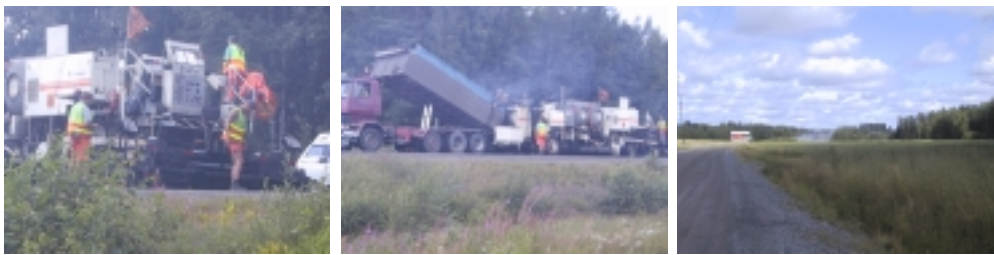
Kuva 27. Tien päällystys hiljaisella asfaltilla.
