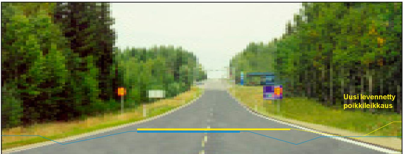
2e Tien oikeaa reunaa on levennetty ja oikeanpuoleista ojaa on muotoiteltu loivemmaksi. Vasen metsänreuna on entisellään, oikeassa reunassa reunakasvillisuutta on poistettu ja rungot paljastuneet näkyviin. Tienvarren rakennuksia paljastuu näkyviin.
