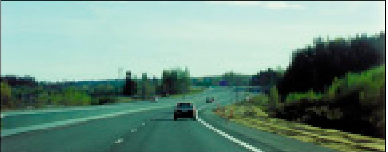
12b Betonikaide asfaltilla. Betonikaide on näkyvä, järeä, optisesti ohjaava ja vähentää vastaan-
