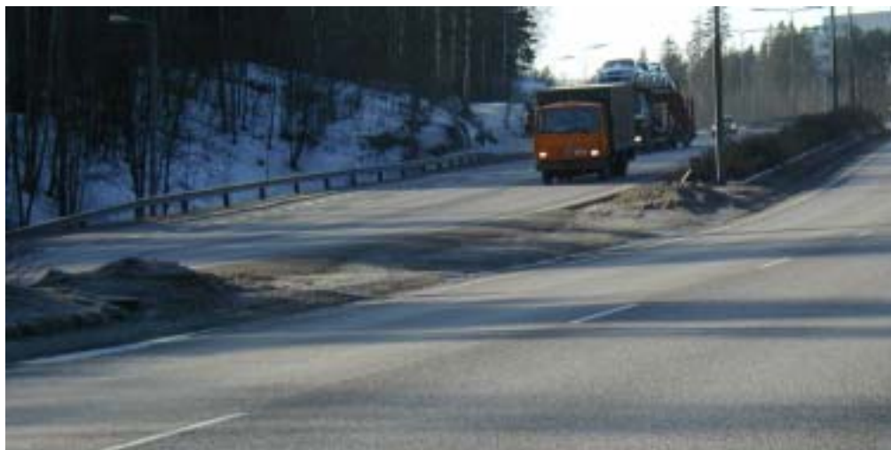
Kuva 9. Nykytilanne: Avoin kulkuaukko Turunväylällä (vt 1), Espoo. Liite 1: Uudenmaan tiepiiri: aukko 2.
