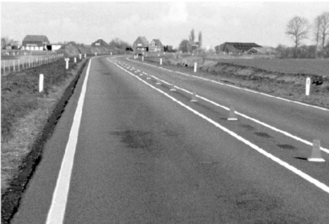
Kuva 8. "Flappen" paalut. (Remeijn 2002).
