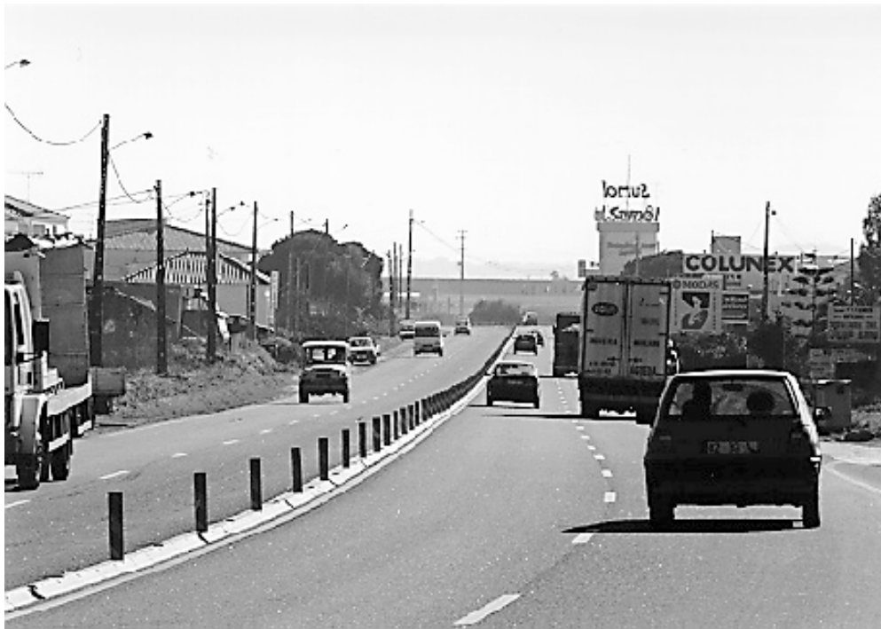
Kuva 13. Muoviset paalut korokkeen päällä (Safestar 1998).
