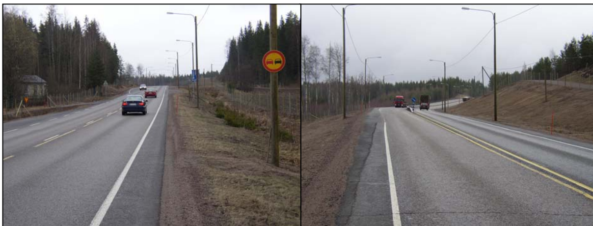
Kuva 6-3. Keskikaiteen länsipää sijaitsee kumpareen (kuva vasemmalla) jälkeisessä kaarteessa (kuva oikealla), jolloin se tulee yllättäen vastaan. Ohituskiellosta ja uudenaikaisesta keskikaiteen varoitusmerkistä huolimatta muutama auto on ajautunut keskikaiteen väärälle puolelle ja ainakin yksi on ajanut koko ohituskaistan "vastavirtaan".
