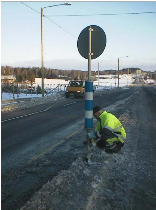
Kuva 3-3. Pääalleajojen vuoksi keskikaiteen alkupäässä olevaa liikenteenjakaajamerkkiä on korjattu monta kertaa.
