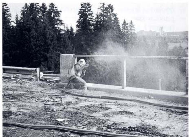
Kuva 7. Suihkupuhdistuksessa syntyy pölyä, jos raemateriaali on kuivaa.
