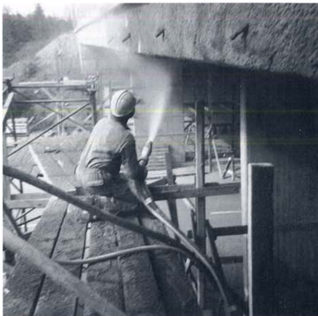
Kuva 9. Betonia ruiskutettaessa leviää roiskeita ja pölyä.
