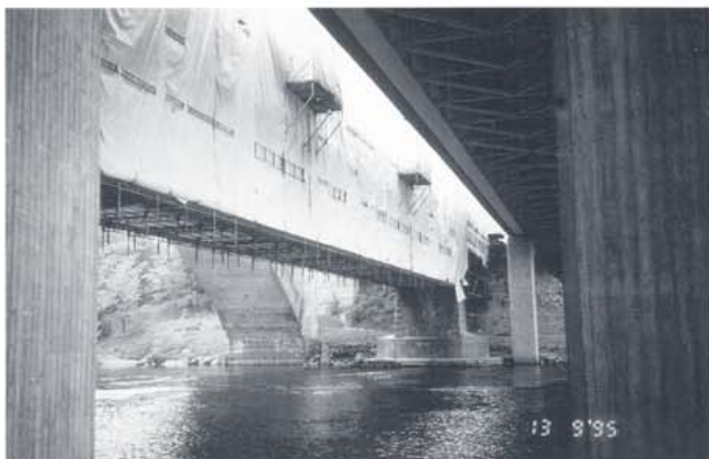
Kuva 1. Pintakäsittelyjätteiden talteenottoa varten rakennettu suoja.
