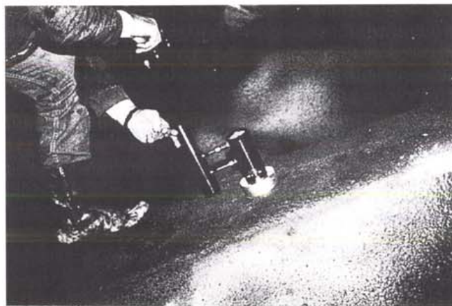
Kuva 33. Ruiskubetonin tartuntalujuuden testaus vetokokeella
