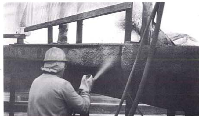
Kuva 6. Reunapalkin ruiskubetonointia. Kaiteet on suojattu hyvin!
