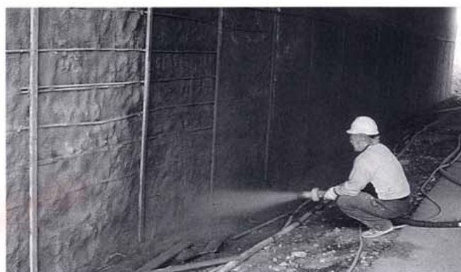
Kuva 2. Betonin ruiskutusta.
