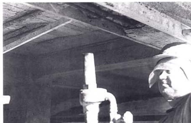
Kuva 16. Betonipeitteen riittävyys on varmistettu muotin avulla.
