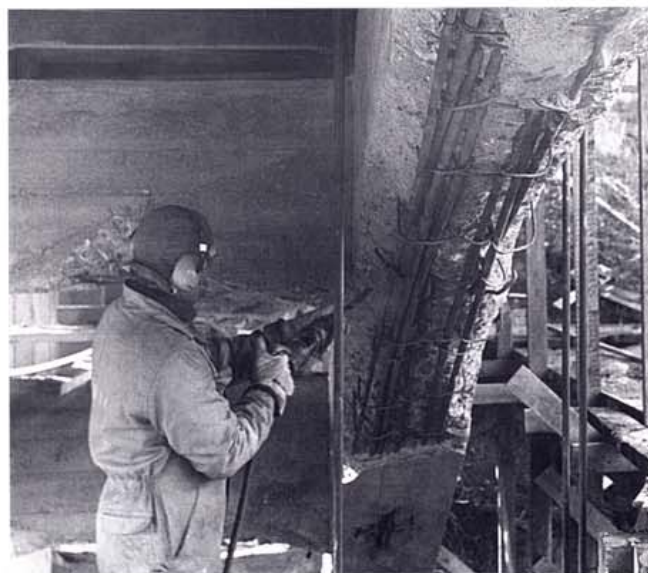
Kuva 26. Ruiskubetonoitavan kaaren piikkausta.
