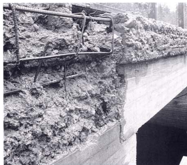
Kuva 27. Maatuen vesipiikattu pinta.
