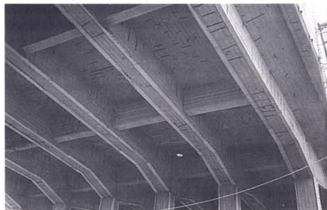
Kuva 29. Palkkien ja pilareiden muodon säilyminen on varmistettu muottien avulla.
