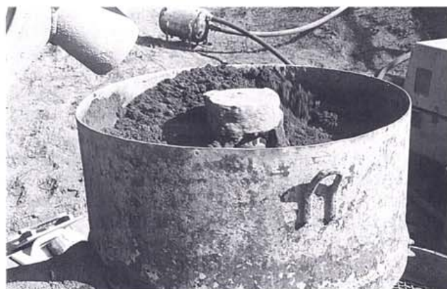
Kuva 28. Ruiskubetonimassan sekoitusta pakkosekoittajalla.
