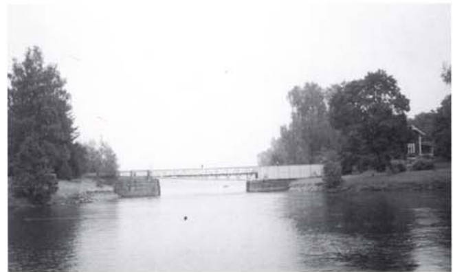
Kuva 16. Vuonna 1897 valmistunut Strömman kanavan ristikkorakenteinen kääntösilta.
