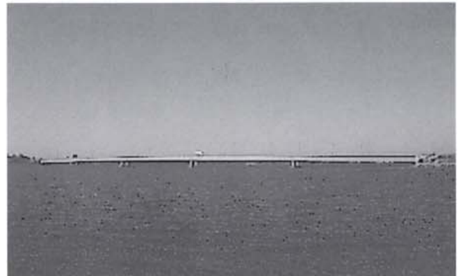
Kuva 15. Vuonna 1965 valmistunut Lapinlahden silta on ensimmäinen teräksinen kotelopalkkisilta.
