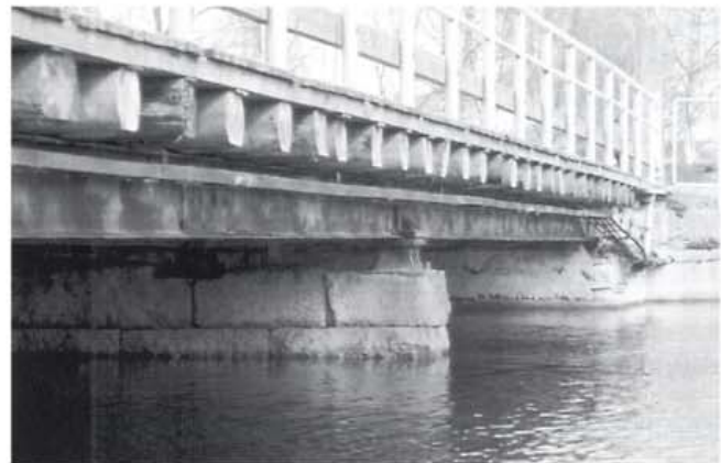
Kuva 7. Taipuma teräspalkissa.
