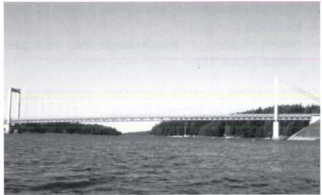
Kuva 14. Vuonna 1964 valmistunut Kirjalansalmen silta on pisin teräksinen riippusilta.
