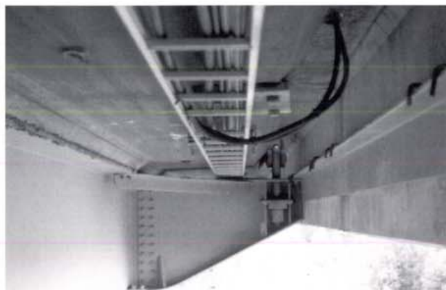
Kuva 3. Kaapelihyllyt valmistetaan alumiinista.
