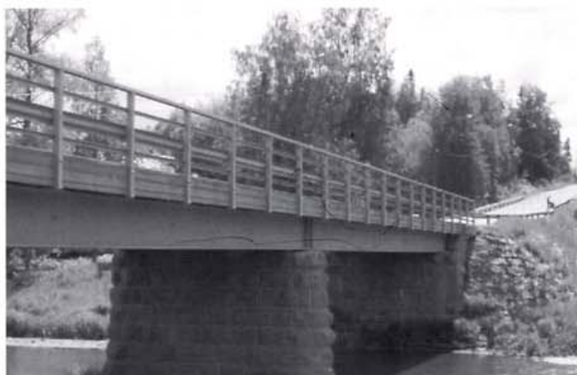
Kuva 1. Teräksinen palkkisilta on yleisin teräsilta.
