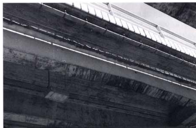
Kuva 12. Törmäysvaurio teräspalkissa.
