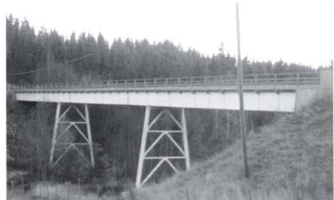
Kuva 17. Puukantinen teräspalkkisilta ja teräsrakenteiset välituet (Saikkalan silta vuodelta 1934).
