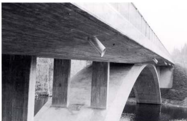
Kuva 2. Syöksytorvet tehdään haponkestävästä teräksestä ja tippuputket ruostumattomasta teräksestä.
