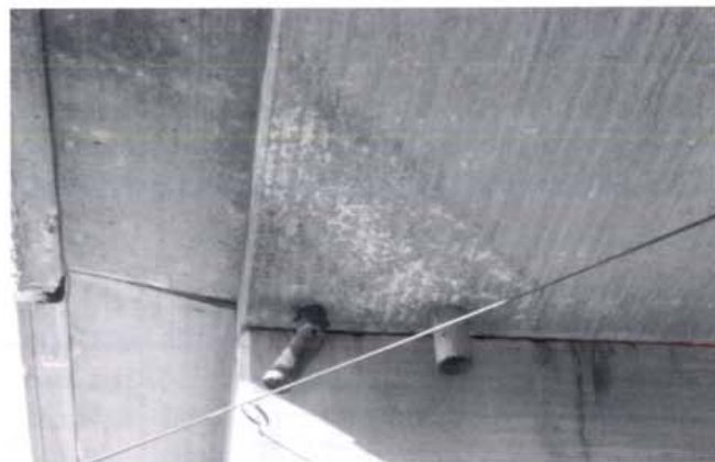
Kuva 13. Jäätymisvaurio syöksytorvessa.
