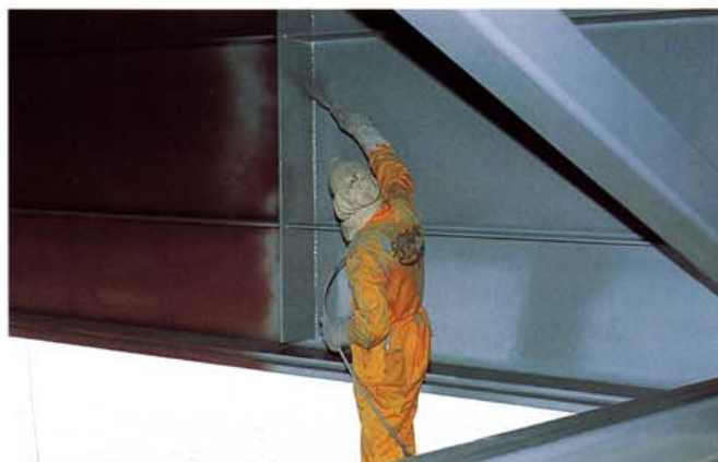
Kuva 47. Uusintamaalaus tehdään yleensä ruiskulla.
