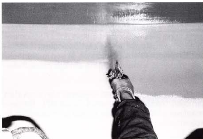
Kuva 50. Suurten pintojen ruiskutus tehdään suoraviivaisesti.
