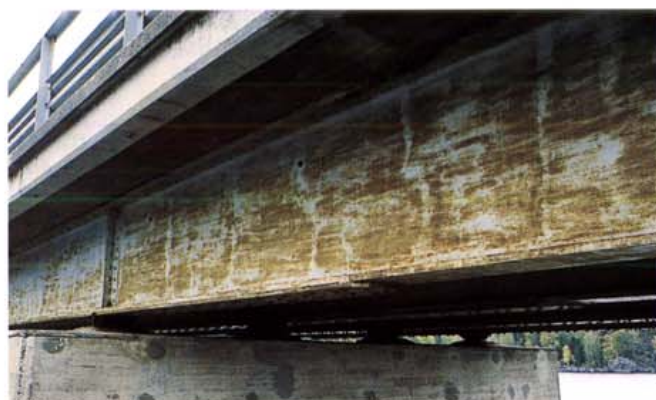
Kuva 31. Puutteellinen esikäsitteily on yleisin syy pinnoitevaurioihin.
