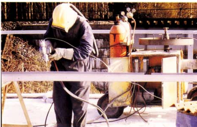
Kuva 53. Lankaruiskutuslaitteisto.
