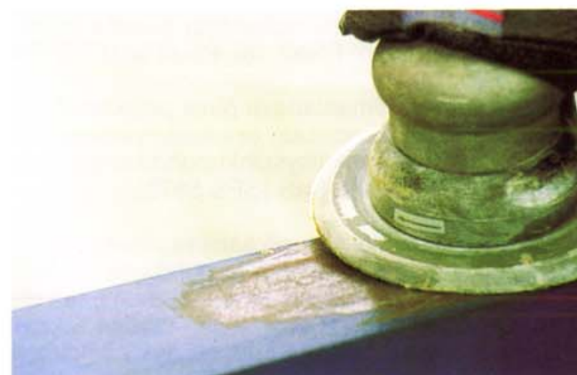
Kuva 38. Puhdistushionta paikkausmaalaukselle varten.
