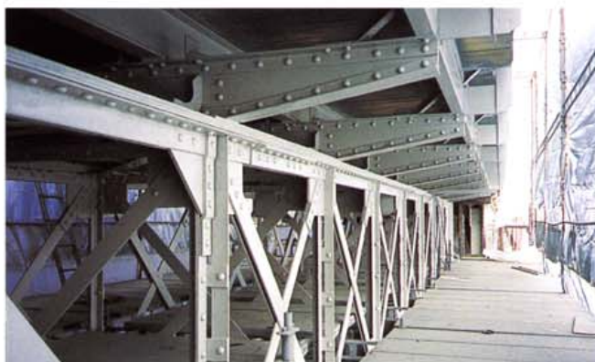
Kuva 28. Sääsuoja ja telineet.
