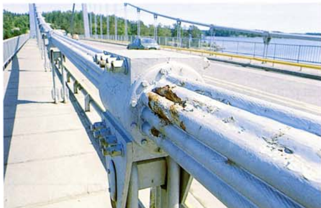
Kuva 44. Tiivistyskittiä on vaurioitettu ilkkivaltaisesti riippuköyden yläpinnassa.
