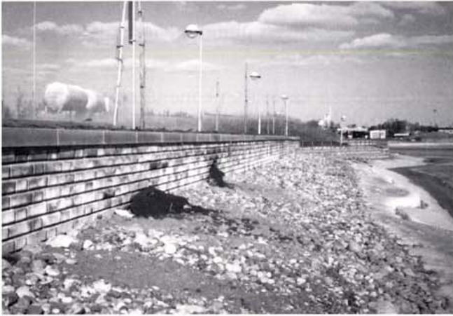
Kuva 31. Lujitemaatukimuuuri siltapenkereen rakenteena
