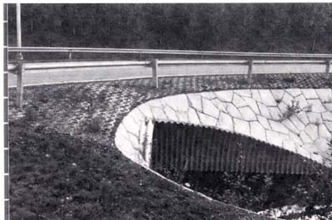
Kuva 36. Huolellisesti tehty kivilaattaverhous
