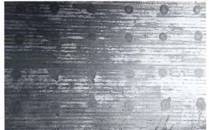
Kuva 4. Häiritsevästi erottuvia paikkauksia.
