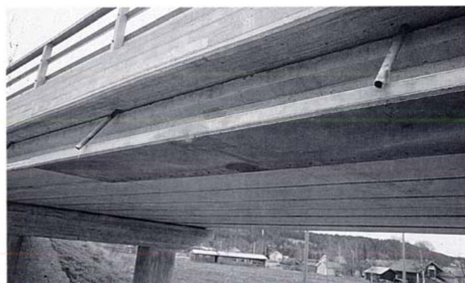
Kuva 4. Törmäysvaurion korjauksessa käytetty teräsmuotti on jätetty paikalleen.
