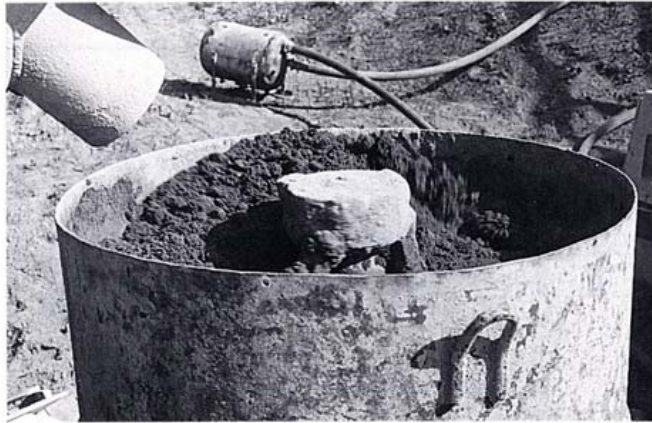
Kuva 12. Betoni sekoitetaan pakkosekoittajassa.
