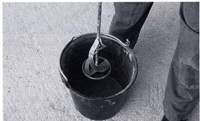
Kuva 13. Paikkauslaasti sekoitetaan porakoneeseen kiinnitetyllä siivikolla.
