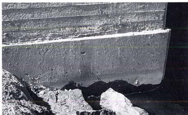
Kuva 3. Kuivatyönä tehty kantamuurin manttelointi.
