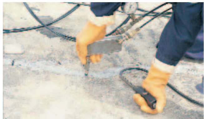
Kuva 4. Injektointilaitte, jossa komponentit sekoittuvat vasta suuttimessa.
