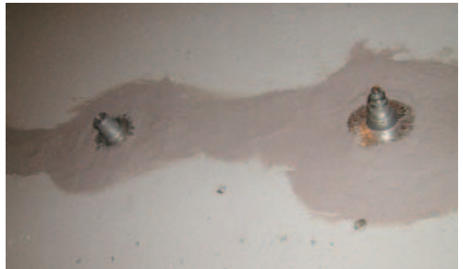
Kuva 8. Aluslevyjä ja toiseen kiinnitetty injektointinippa.
