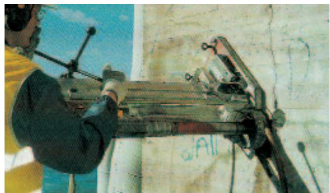
Kuva 5. Ennakkokokeen tulos tarkistetaan rakenteesta porattavasta näytteestä.
