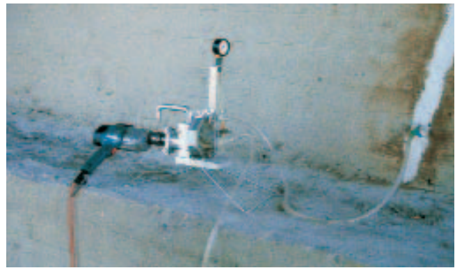
Kuva 3. Injektointilaite ja suutinpainemittari.
