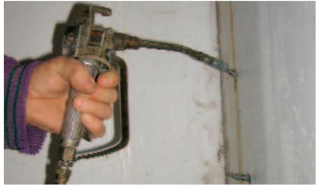
Kuva 7. Mansetilla kiinnitettäviä injektointitulppia.
