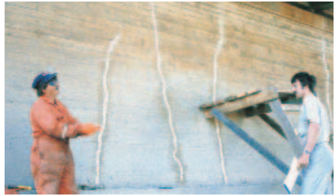
Kuva 11. Injektointityö on valmistettava huolellisesti.
