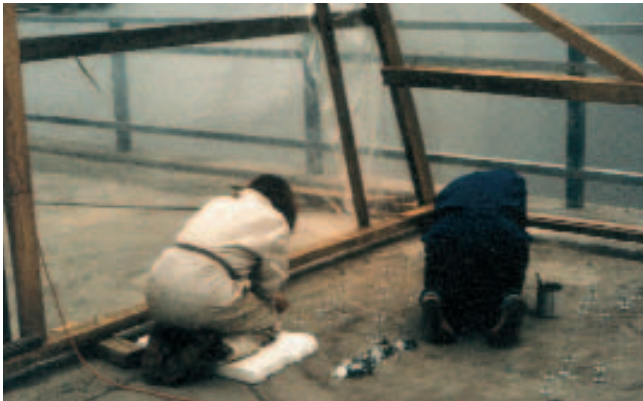
Kuva 15. Kansilaatan injektointia valmistellaan sääsuojassa.
