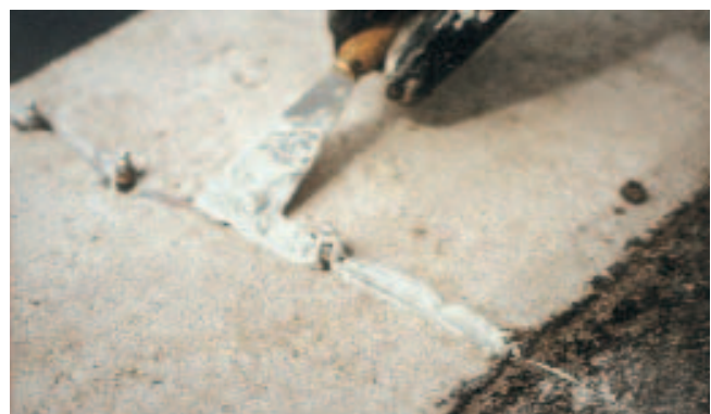
Kuva 6. Sulkuaine levitetään lastalla.
