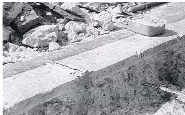
Kuva 5. Halkeaman kohdalle tehdään kaukalo.
