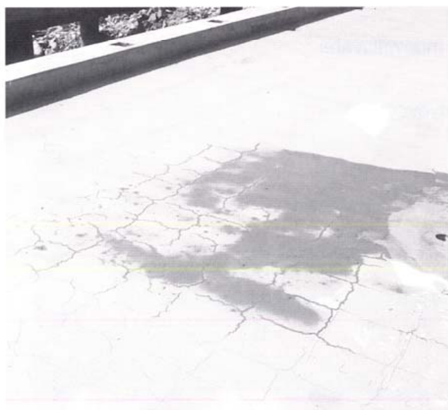
Kuva 2. Kansilaatan plastiset halkeamat paljastuvat yleensä suihkupuhdistuksen jälkeen ja erottuvat hyvin kuivuvasta pinnasta.
