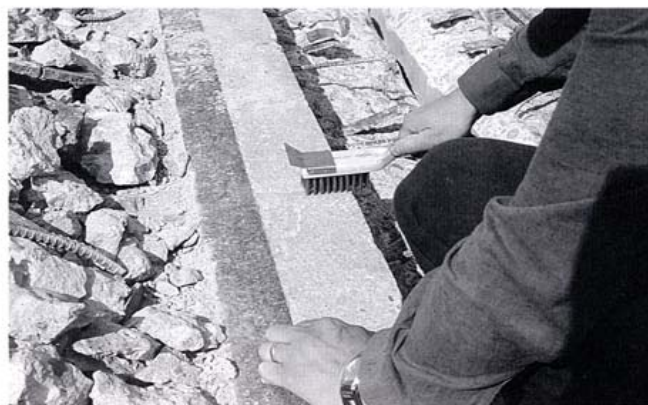
Kuva 4. Halkeaman pinta puhdistetaan.
