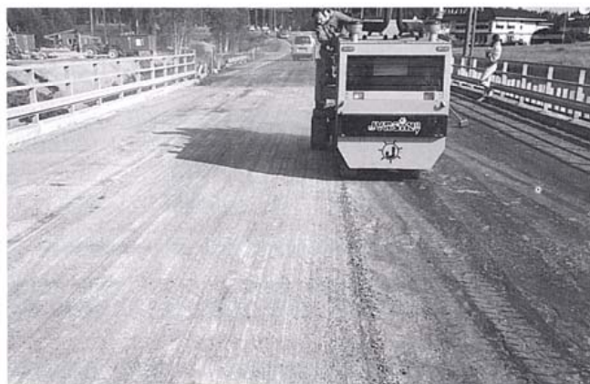
Kuva 4. Kansilaatan pintaa poistetaan voimakkaalla jyrsimellä.
