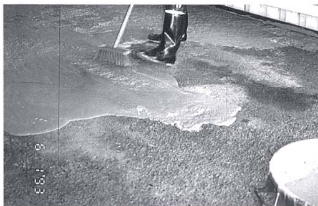
Kuva 7. Tartunta-aine levitetään harjaamalla.
