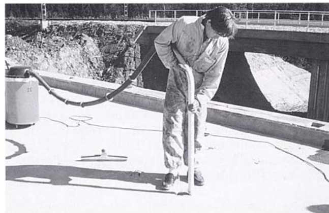
Kuva 13. Lopuksi eristysalusta puhdistetaan imuroimalla.
