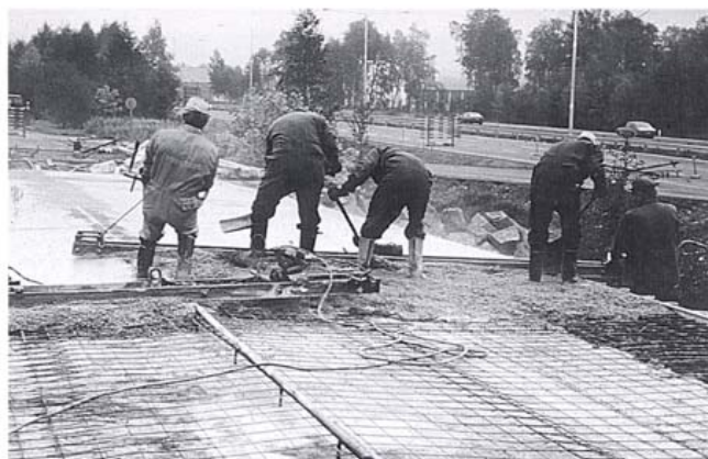
Kuva 8. Betonimassa tiivistetään tärypalkilla.
