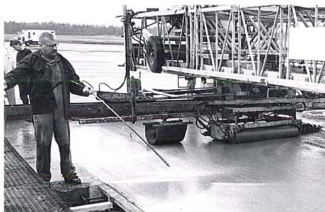
Kuva 10. Jälkihoitoaine levitetään ruiskulla.
