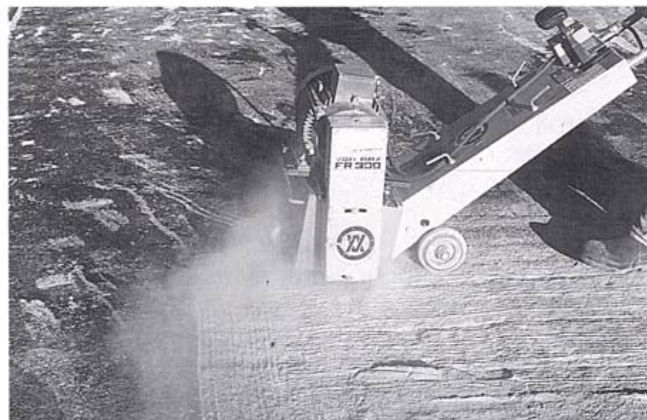
Kuva 5. Pienet alueet jyrsitään kevyellä jyrsimellä.
