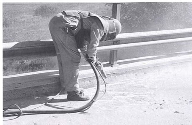
Kuva 12. Eristysalusta suihkupuhdistetaan välittömästi ennen vedeneristystyötä.
