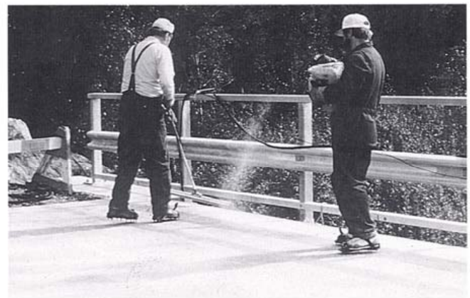
Kuva 17. Epoksin ja sirotteen levitystä.
