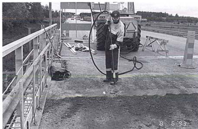
Kuva 11. Vanha kermieristys poistetaan petkeleellä.
