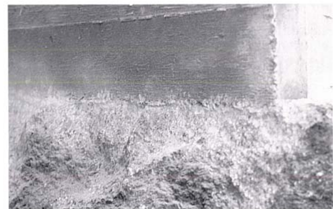
Kuva 11. Neulahakkurilla puhdistettu kivipinta.
