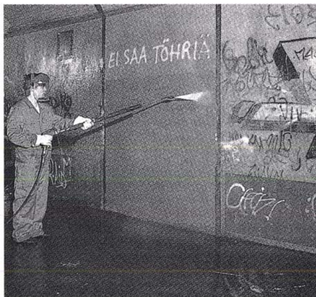
Kuva 2. Töherryksiä poistetaan kemikaalikäsittelyn jälkeen painepesurilla.
