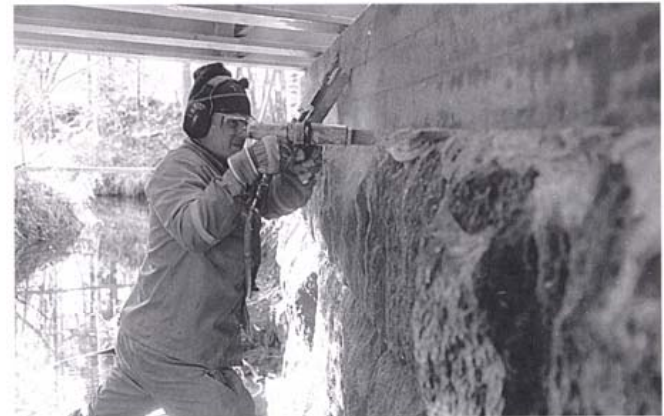
Kuva 10. Kivipintaa puhdistetaan neulahakkurilla.
