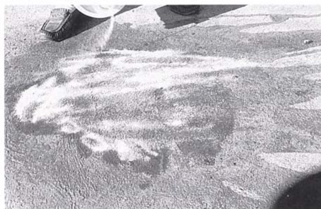
Kuva 5. Öljynpoistoaine levitetään märälle pinnalle.
