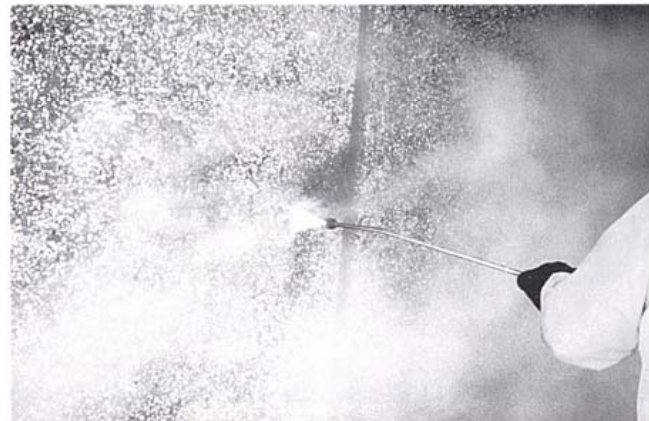
Kuva 13. Pinnan pesu suurpaine pesurilla on alkamassa.
