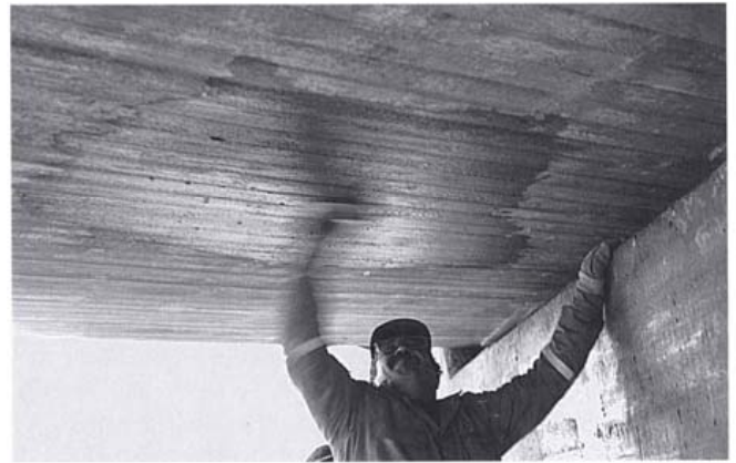
Kuva 8. Paikallinen kalkkitahra saadaan yleensä pois vedellä ja harjalla.
