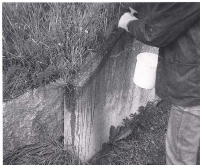
Kuva 16. Kasvinpoistoliuosta levitetään siipimuurin pinnalle.
