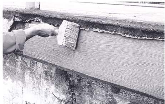
Kuva 10. Sementtipohjaisen pinnoitteen pohjustusta harjalla.
