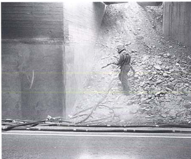
Kuva 6. Pintaa suihkupuhdistetaan hiekkapuhaltamalla.
