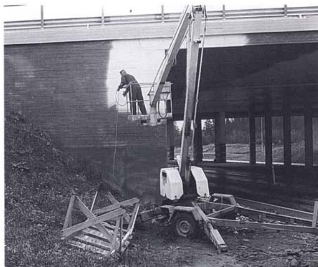
Kuva 5. Pinnoitusta henkilönostimen korista käsin.
