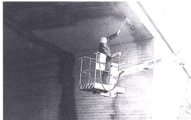
Kuva 9. Tartunta-aineen levitystä ruiskulla.
