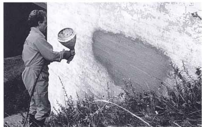
Kuva 11. Sementtipohjaisen pinnoitteen levittämistä ruiskulla.
