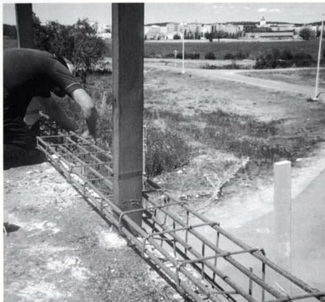
Kuva 1. Tartuntoja tarvitaan yleisimmin reunapalkkia uusittaessa.
