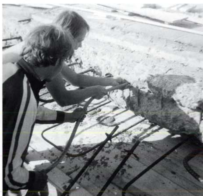
Kuva 2. Tartuntateräksiä tarvitaan, kun uusi rakenneosa liitetään vanhaan.
