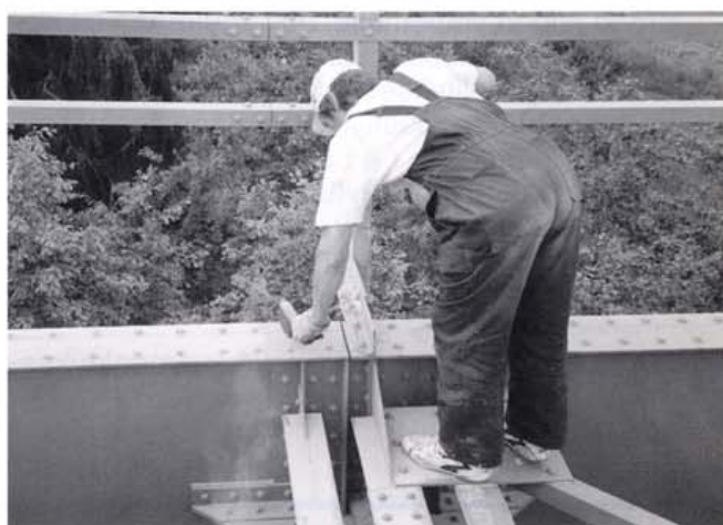
Kuva 10. Maalattavan pinnan on oltava puhdas.
