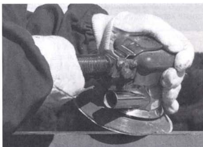
Kuva 7. Paikalleen jäävän maalin reuna on hiottava.
