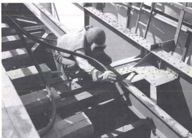
Kuva 6. Teräspalkkien suihkupuhdistusta.
