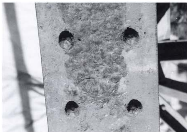
Kuva 9. Paksu ruostekerros on poistettu ensin.
