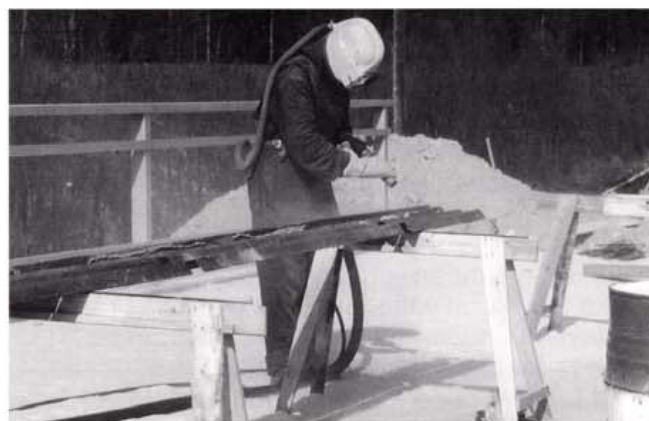
Kuva 4. Maalattavan sinkkipinnan suihkupuhdistusta.
