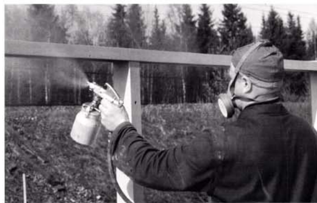
Kuva 5. Sinkkipinnan maalausta ruiskulla.
