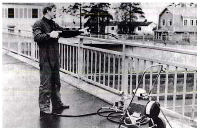
Kuva 3. Maalattavan sinkkipinnan pesua.
