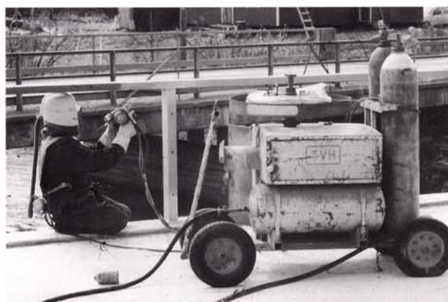
Kuva 8. Kaiteen ruiskusinkitystä.
