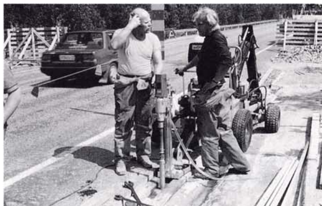
Kuva 7. Tippuputken reikä porataan lieriöporalla.
