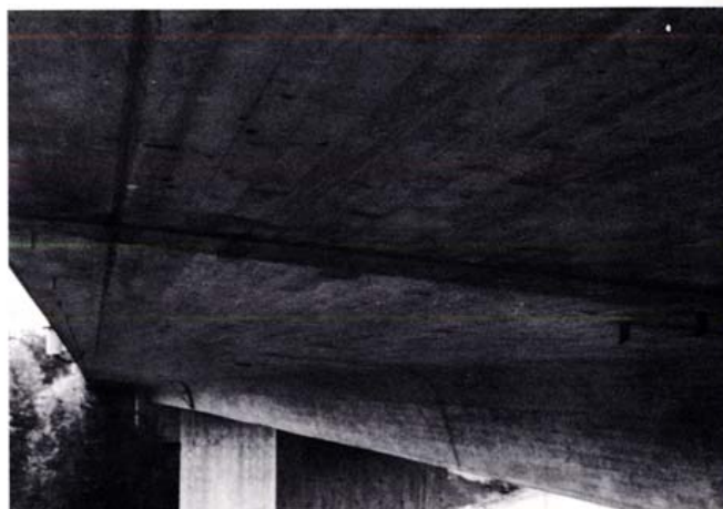
Kuva 10. Tippuputket on liimattu reunapalkin alapintaan
