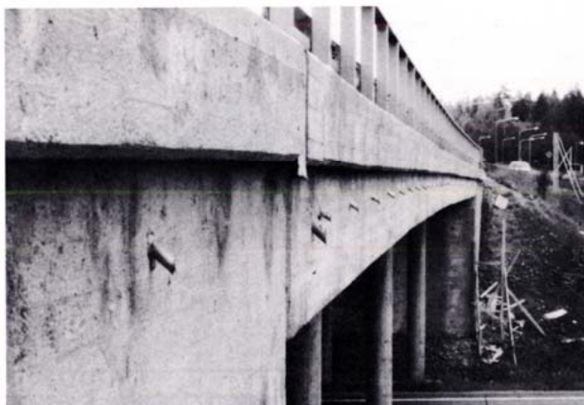
Kuva 9. Tippuputket on liimattu kansilaatan sivupintaan
