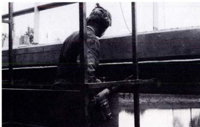
Kuva 3. Tippureiät porataan yleensä kaiteen varassa liikuteltavasta hoitokorista
