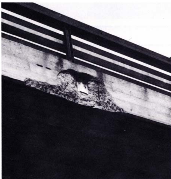
Kuva 1. Lohkeama kansilaatan sivupinnassa
