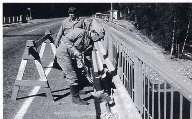
Kuva 8. Ympärystäyttö tehdään sidotusta kiviaineksesta
