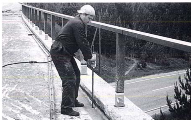
Kuva 5. Tippuputket avataan ja kunnostetaan ja salaojaprofiili sovitetaan etukäteen
