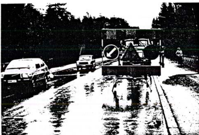
Kuva 6. Liikenteenjärjestelyt ovat tarpeen
