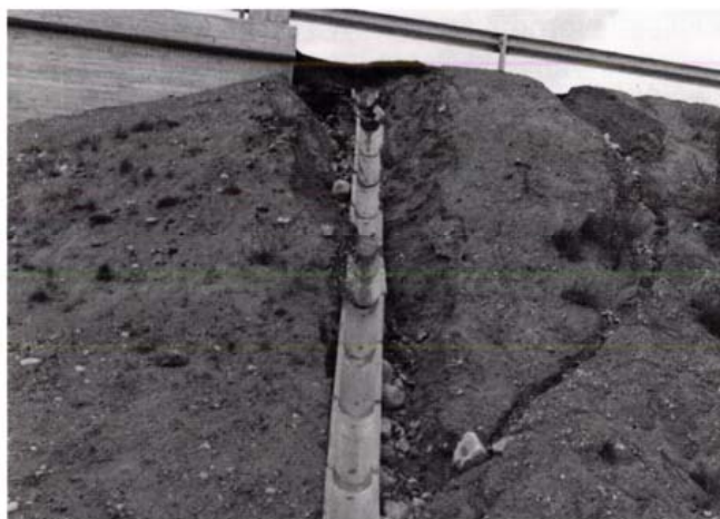
Kuva 13. Eroosioaurio kourun vieressä.
