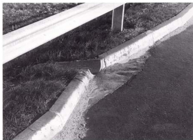
Kuva 7. Hyvin vettä ohjaava suppilo kourun yläpäässä.
