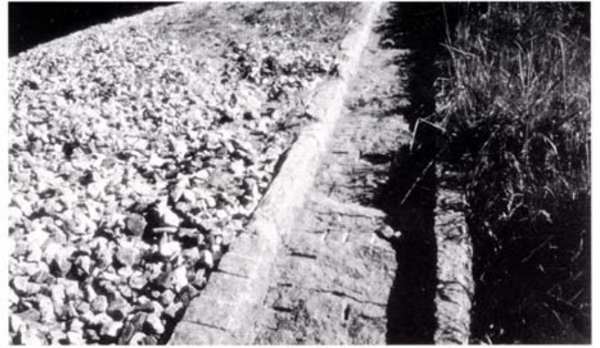
Kuva 9. Kivilaatoista tehty kouru.
