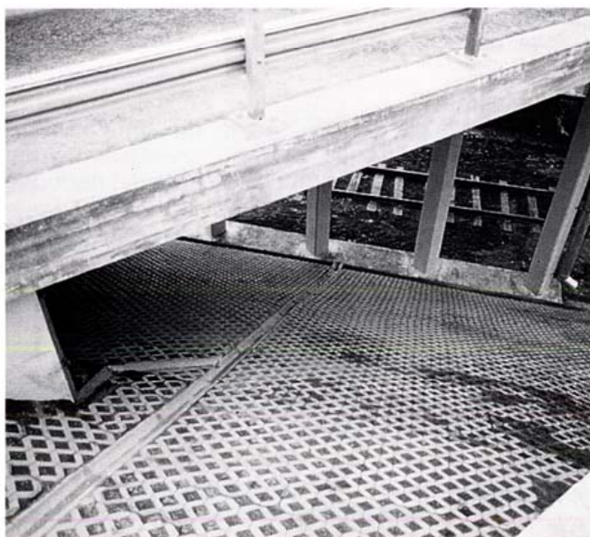
Kuva 2. Pintavesikouru etuluiskassa.
