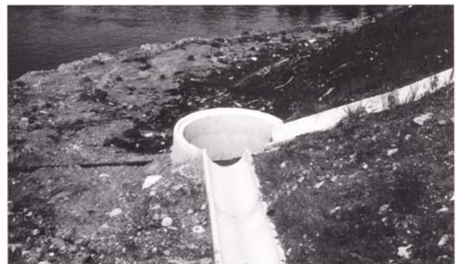
Kuva 11. Kaivonrengas pintavesikourujen alapäässä.
