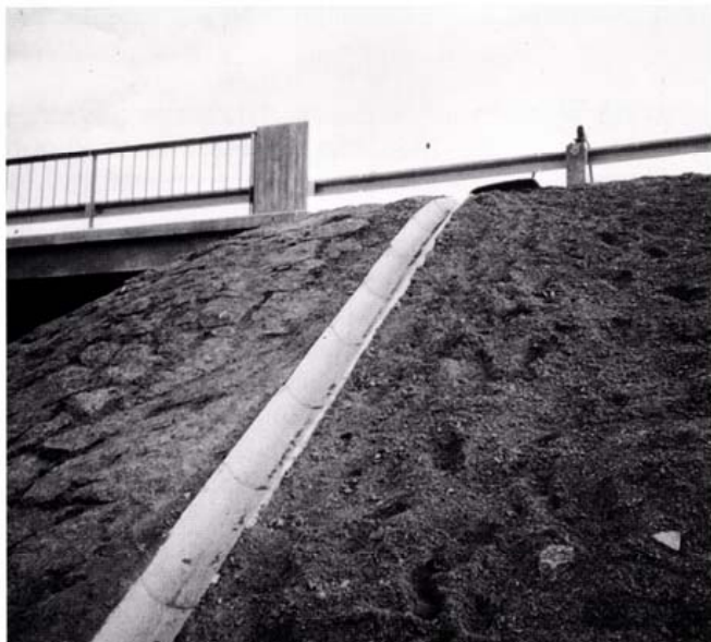
Kuva 1. Pintavesikouru keilan takana.
