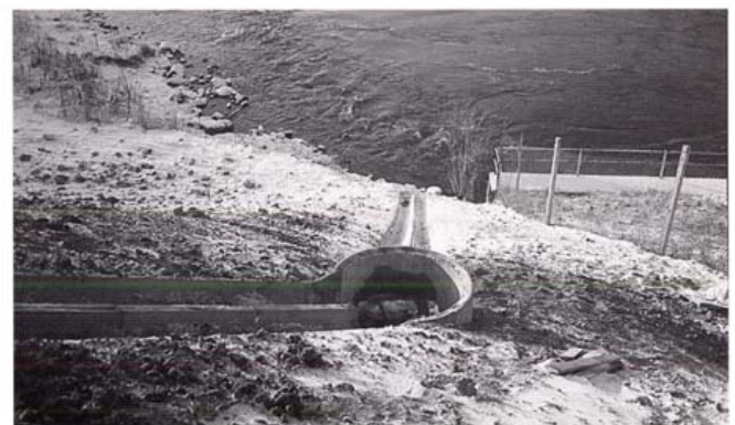
Kuva 12. Kaivonrengas pintavesikourun taitteikohdassa.
