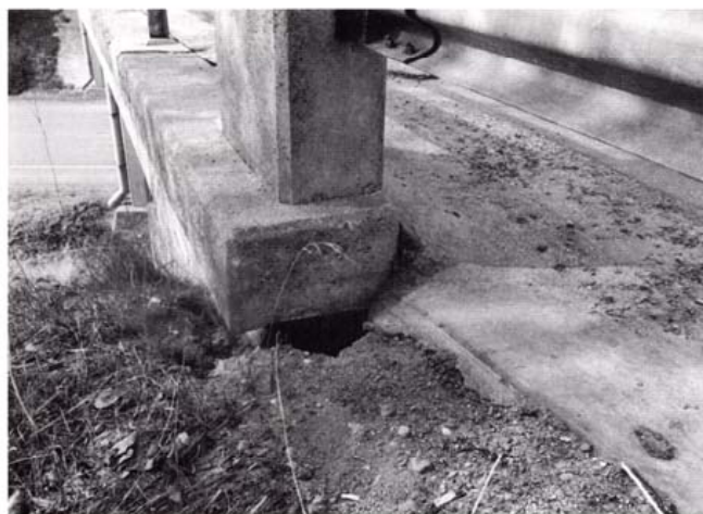
Kuva 14. Kouru puuttuu.
