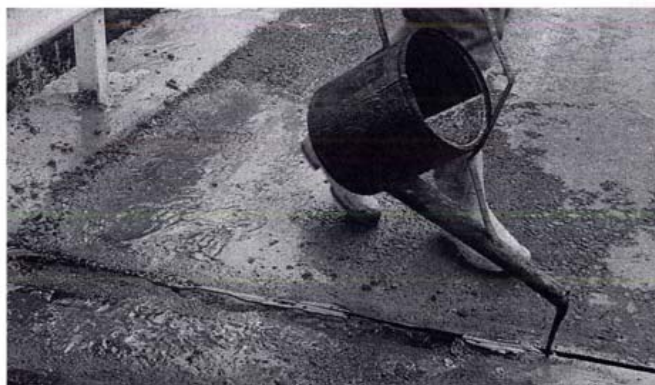
Kuva 24. Tukikaistan reuna saumataan
