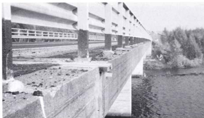
Kuva 3. Liikuntasaumalaite on ulotettu reunan ulkopuolelle
