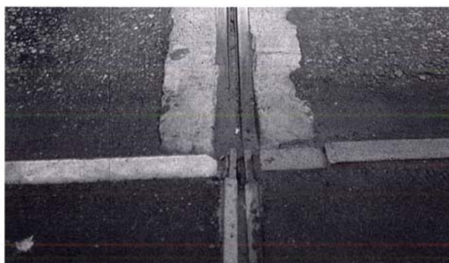
Kuva 23. Jalkakäytävän päällyste on liitetty suoraan saumalaitteeseen
