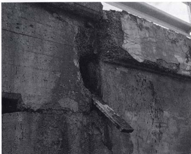
Kuva 1. Suolakorroosioaurioita liikuntasaumassa
