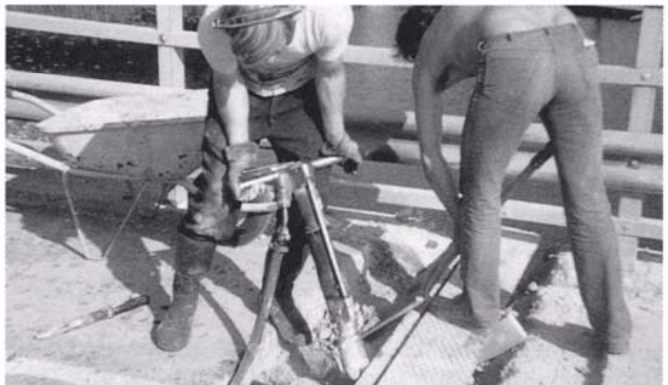
Kuva 8. Vanhojen rakenteiden purkamista
