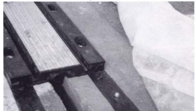
Kuva 12. Liikuntasaumalaite asennettuna tiivistysnauhan päälle
