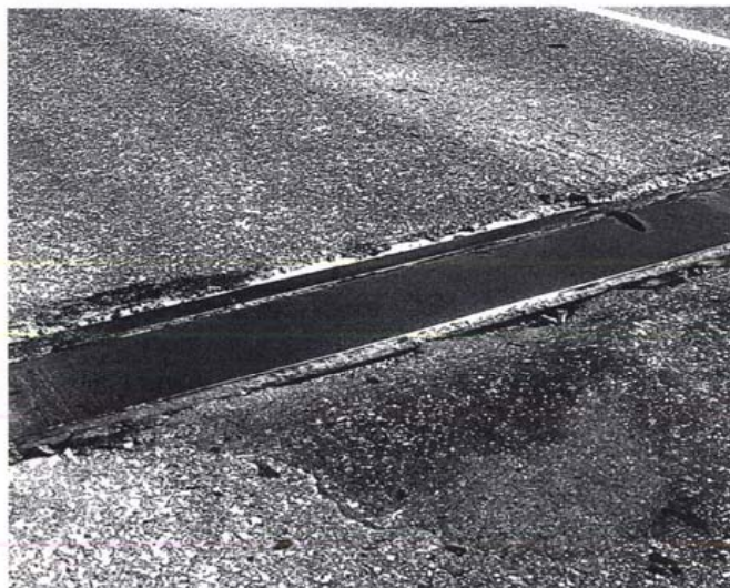
Kuva 2. Irronnut liikuntasaumalaite
