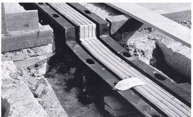
Kuva 10. Taitteet on syytä tehdä saumalaitteisiin tehtaalla
