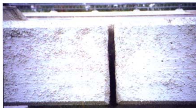
Kuva 5. Esipuristettu paisuva saumanauha.
