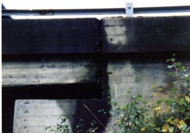
Kuva 1. Avonaisesta saumasta valuva suolainen vesi vaurioittaa alapuolisia rakenteita.
