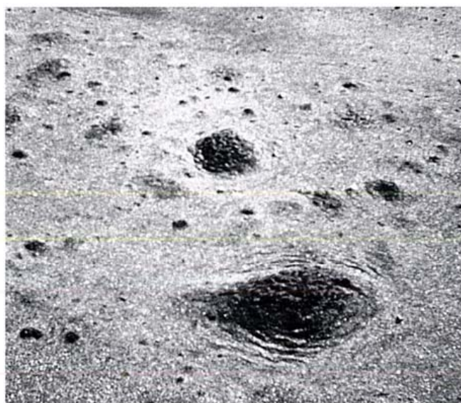
Kuva 2. Jos alustan kosteudesta johtuvia kuplia on paljon, rakenteet on yleensä tehtävä uudestaan.
