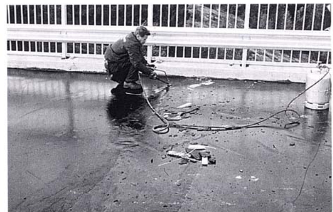
Kuva 11. Työsauman tiivistys.
