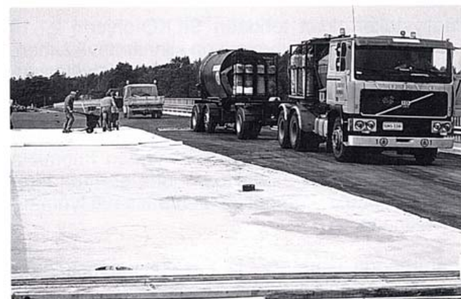
Kuva 7. Paineentasausverkko asennettuna.
