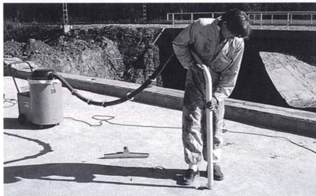
Kuva 7. Eristysalusta puhdistetaan imuroimalla
