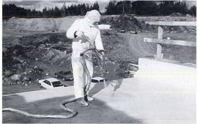
Kuva 13. Eristysmassan ruiskutusta
