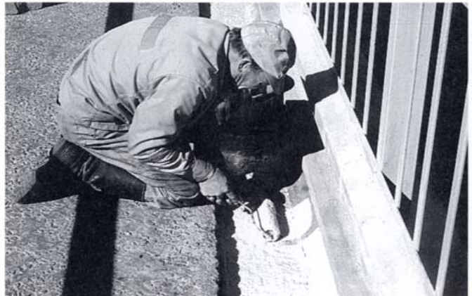
Kuva 14. Eristysmassan levitystä käsityönä
