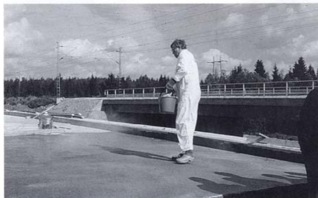
Kuva 8. Eristysalustalle levitetään esisivelyaine ja tartuntasirote
