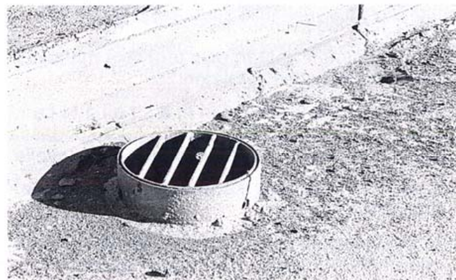
Kuva 12. Kuivatuslaitteet ja muut läpiviennit tiivistetään huolellisesti
