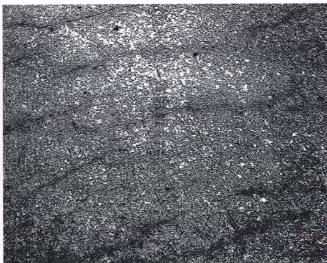
Kuva 2. Jos kansilaattaan on tullut plastisesta kutistumisesta tai painumisesta johtuneita halkeamia, massaeristys on usein suositeltava vaihtoehto.
