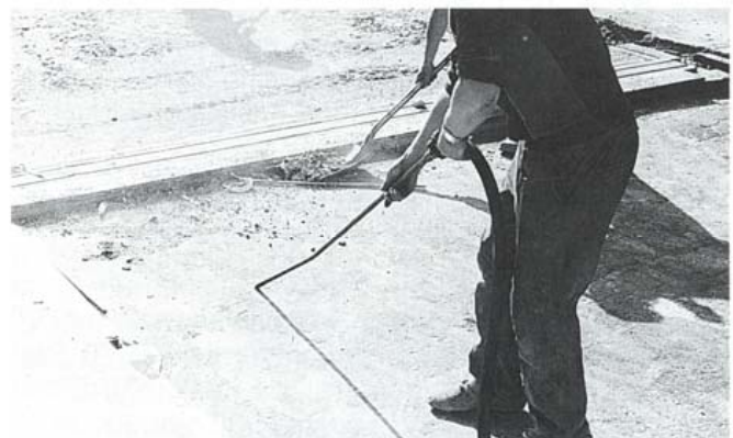
Kuva 8. Päällystysalustan puhdistusta.
