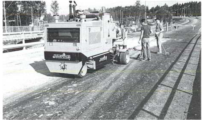
Kuva 5. Vanha päällyste puretaan voimakkaalla jyrsimellä.
