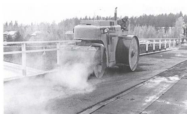
Kuva 11. Asfaltti levitetään asfaltinlevittimellä ja jyrätään valssiyrällä.
