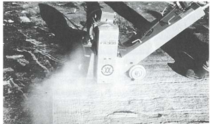
Kuva 6. Reunat ja muut vaikeapääsyiset kohdat jyrsitään pienemmällä jyrsimellä.
