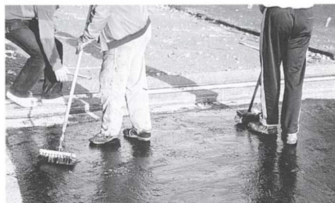
Kuva 10. Päällyste liimataan suojabetoniin.
