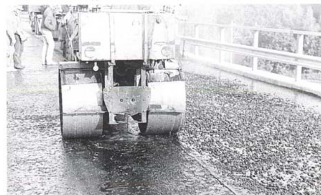
Kuva 12. Valuasfaltin pintaan sirotellaan bitumoitua murske.
