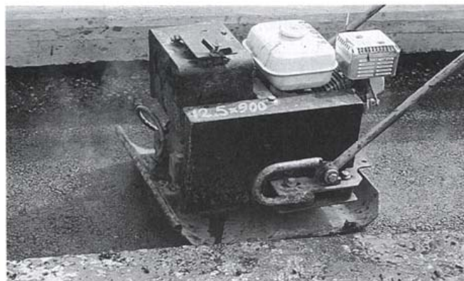
Kuva 9. Epätasaisuudet korjataan tasausmassalla.
