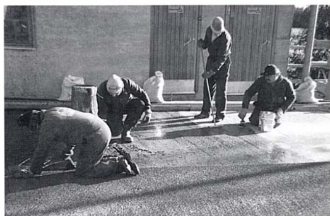
Kuva 8. Tartunta-aineen levitystä.
