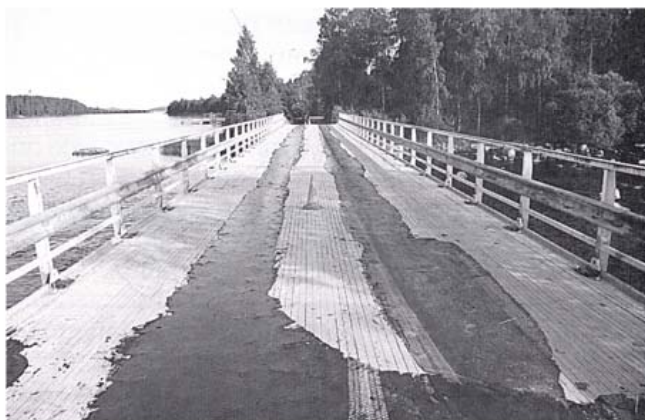
Kuva 5. Kulumisurien täyttö.
