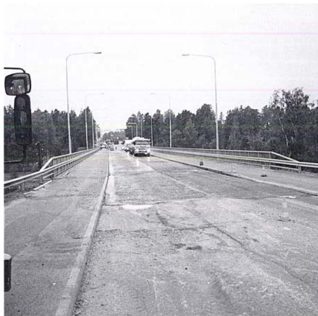
Kuva 3. Päällyste on tehty ajokaista kerrallaan.
