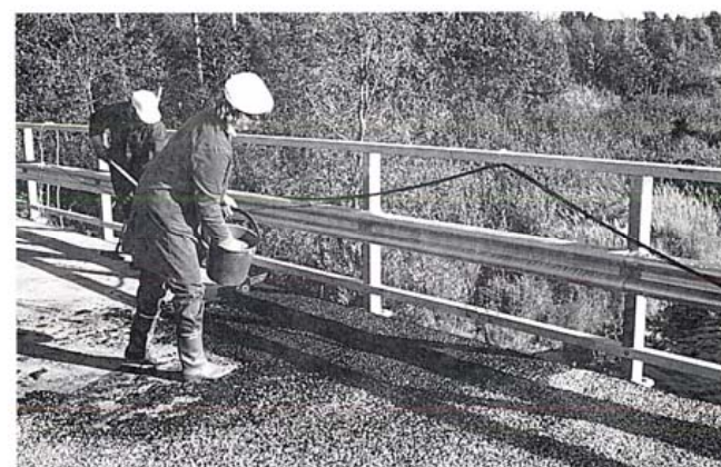
Kuva 11. Pinta karkeutetaan sirotteella.
