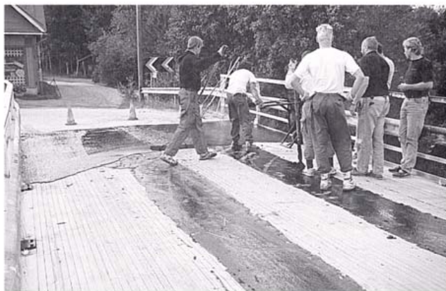
Kuva 6. Mastiksin levitystä.
