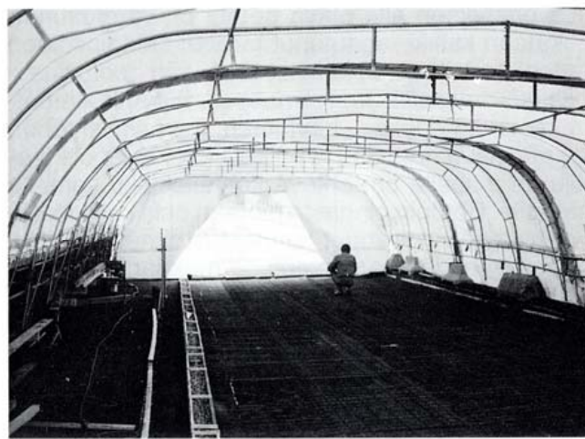
Kuva 4. Vedeneristystöissä on varauduttava sään vaihteluihin.
