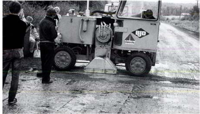
Kuva 5. Pintakerrosta puretaan jyrsimällä.
