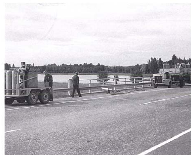
Kuva 1. Kumibitumin sulatuspata, kuumailmapuhallin, kompressori ja kaasupullot auton lavalla.
