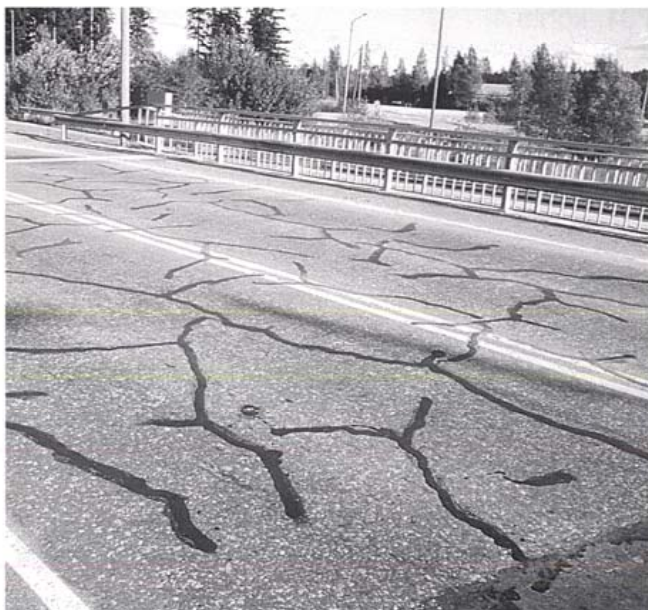
Kuva 2. Korjatun halkeaman kuntoa on seurattava ja mahdolliset vauriot on korjattava ensi tilassa
