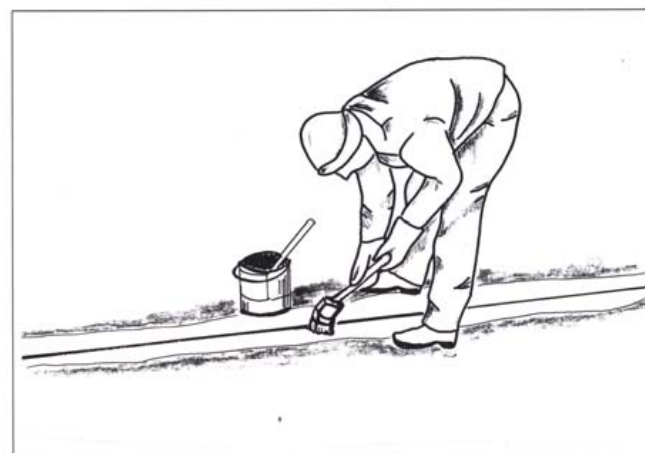
Kuva 8. Ura esikäsitellään tartunta-aineella.
