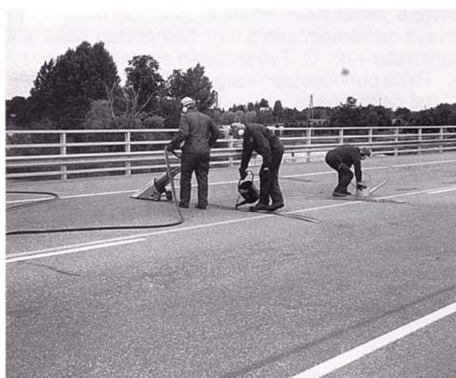
Kuva 5. Työvaiheet; kuumailmapuhallus, saumaus ja sirotteen levitys.
