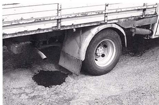
Kuva 17. Tilapäinen paikkaus voidaan tiivistää autonpyörällä.
