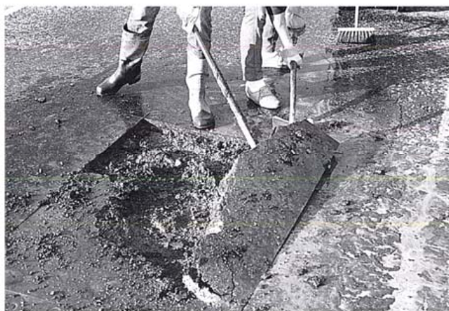
Kuva 5. Vaurioituneen päällysteen purkamista.
