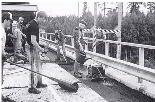
Kuva 12. Sillan reunan paikkausta asfalttibetonilla.
