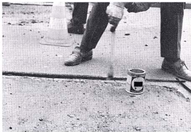
Kuva 7. Saumausnauhan tartuntapinnan tartunta-sivelyä.
