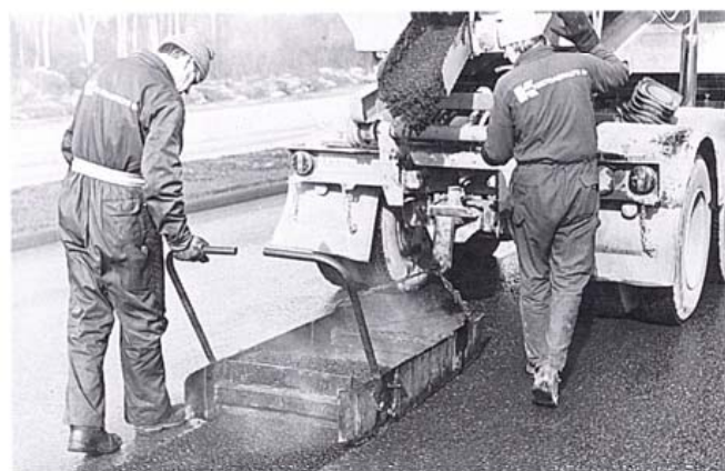
Kuva 9. Asfaltin levitystä laahaimella.
