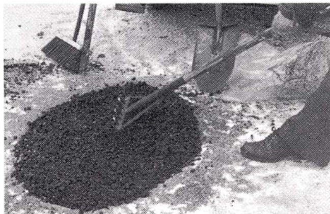
Kuva 16. Tilapäinen paikkaus voidaan tehdä kylmällä massalla.
