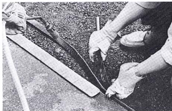
Kuva 8. Saumausnauha lämmitetään kaasuliekillä ja kiinnitetään lastalla.
