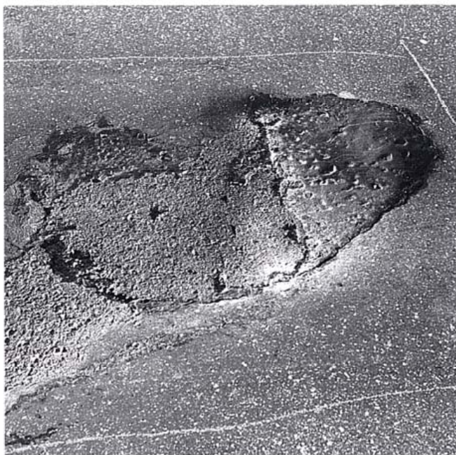
Kuva 1. Purkautunut asfalttipäällyste.
