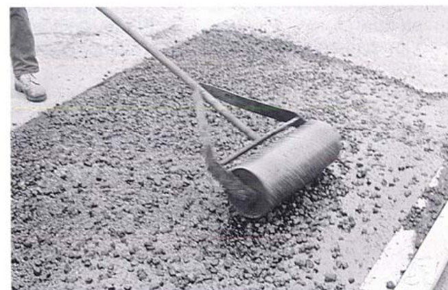
Kuva 11. Paikan pinta jyrätään.
