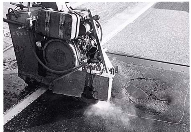
Kuva 4. Paikan reunat sahataan pystysuoriksi.
