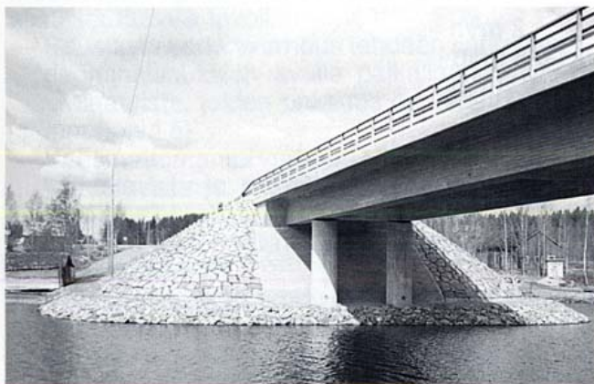
Kuva 1. Tyylikkäät keilaverhoukset on tehty omalla painollaan paikallaan pysyvistä kivilaatoista.
