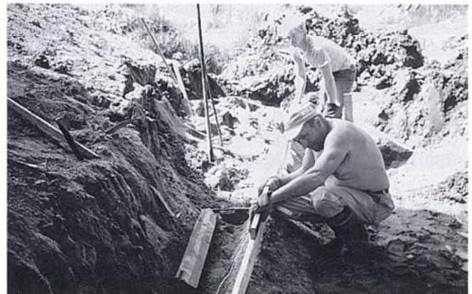
Kuva 12. Juurikivet on asennettava huolellisesti.
