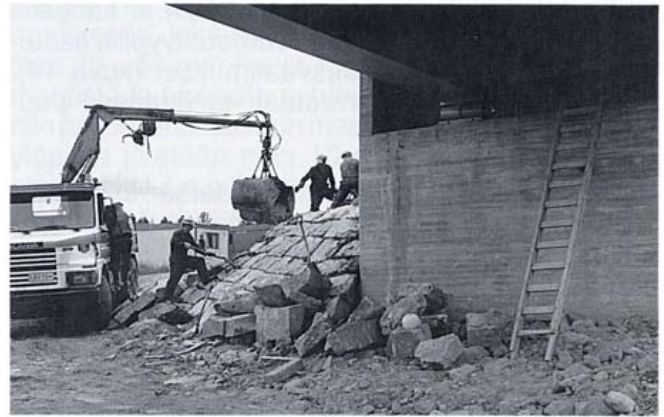
Kuva 11. Verhoustyön nostot ja siirrot tehdään mahdollisuuksien mukaan konetyönä.
