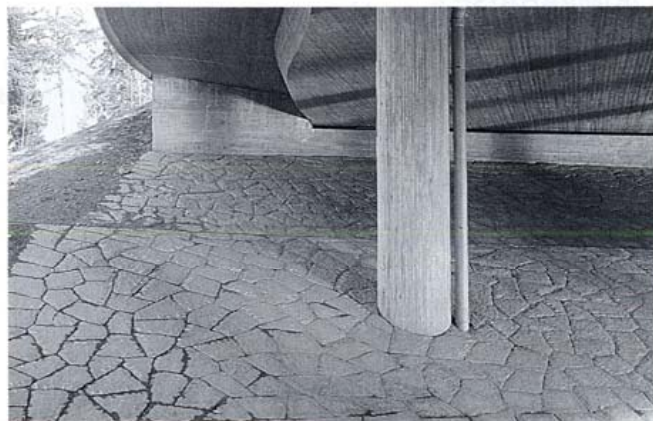
Kuva 2. Etuluiskaa elävöittävä verhous on tehty sideominaisuuksiltaan paikallaan pysyvistä kivilaatoista.
