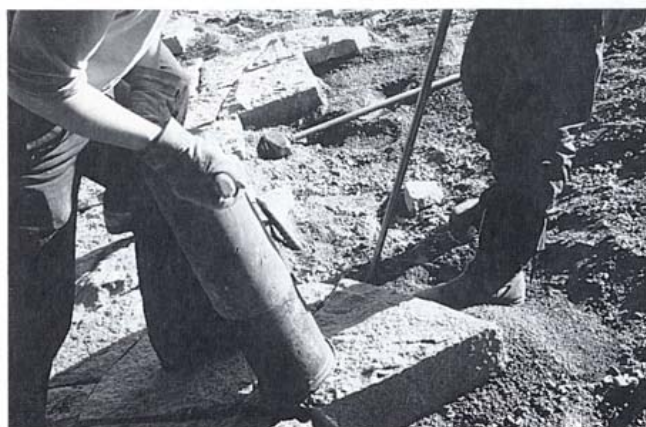
Kuva 15. Kiven alusta on tiivistettävä.
