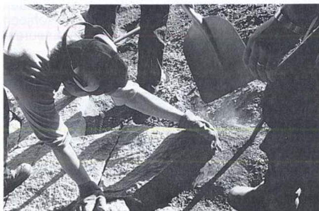
Kuva 14. Kivilaatan pitää sopia hyvin paikalleen.
