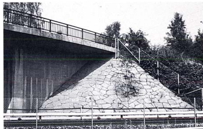
Kuva 6. Epäsäännöllisistä kivilaatoista tehty verkko-verhous.
