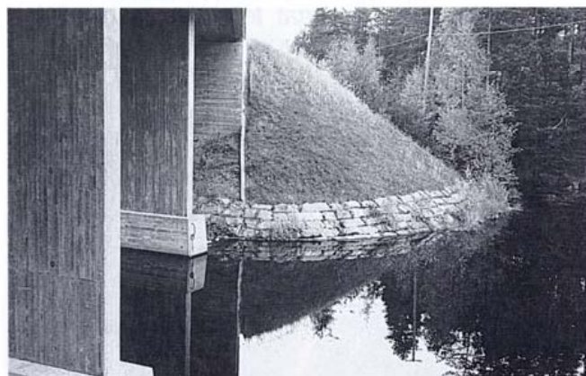
Kuva 4. Palkkiverhous keilan alaosa.
